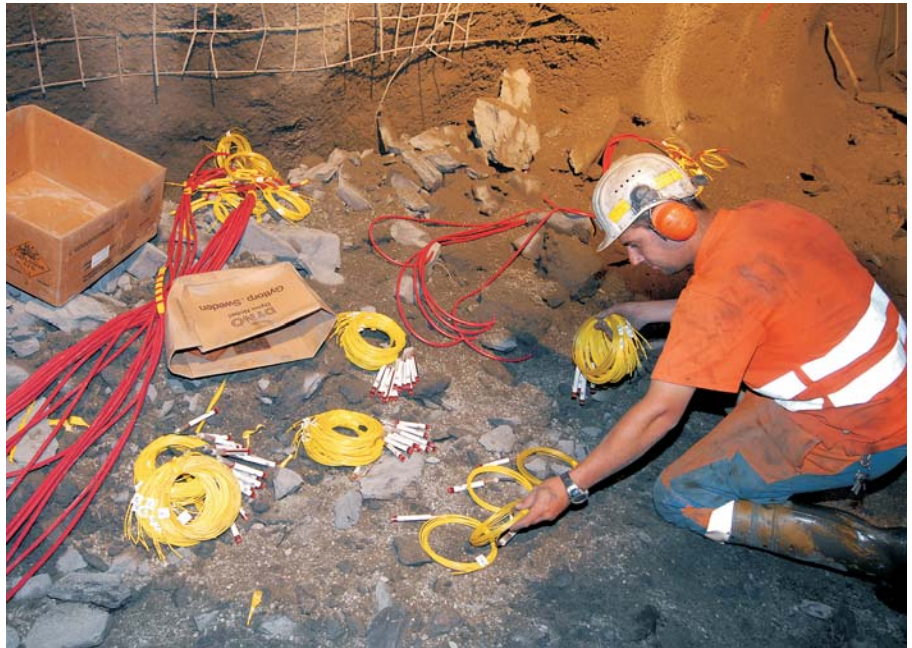
Bereitstellen der Zünder für die nächste Sprengetappe
