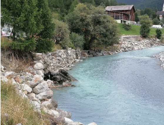
Abbildung 27: Best. übersteile Ufermauer soll rückgebaut werden (Foto: P. Mosimann).
