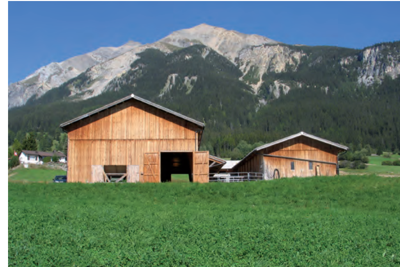
Lantsch / Lenz Die Funktionsfläche wurde auf zwei Baukörper verteilt. Das breitere und höhere Gebäude dient als Futterterrass und Futterlager, im kleineren Trakt befindet sich die Liegehalde. Beide Bauten wurden aufeinander abgestimmt. Dachform und Fassadenmaterialien verbinden die Bauten zu einer Einheit.
