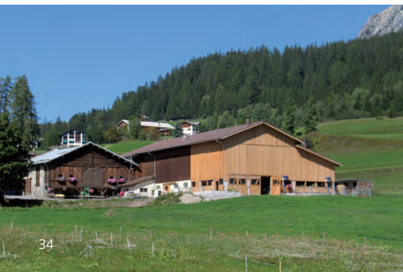
Lantsch / Lenz Die Erweiterung am alten Stall ist mit der gleichen Dachform und -material gedeckt. Die Stallverbreiterung über das ursprüngliche Mass des Bestands hinaus ist mit einem Absatz zum Hauptdach markiert.
