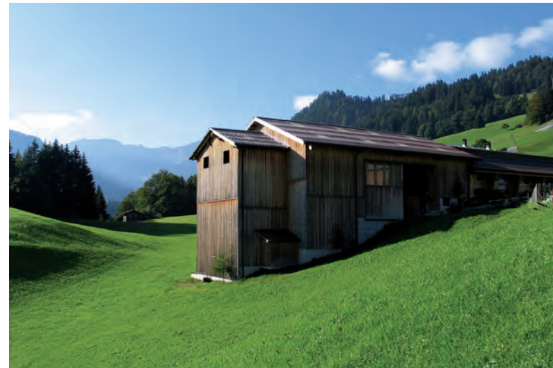
Valzeina Der giebelständige Stall steht senkrecht zu den Höhenlinien. Die Mehrgeschossigkeit des Gebäudes ist ablesbar, die verschiedenen Ebenen auf den Hangverlauf abgestimmt.
