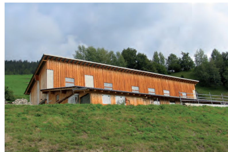
Ruschein Die Gebäudehöhen sind der Nutzung angepasst. Unter dem niedrigeren Gebäudeteil befinden sich die Liegeboxen, unter dem höheren das Futterlager. Das Volumen des Gebäudes ist durch diese Massnahme auf das notwendige Mass reduziert worden, es entstand ein gegliederter Bau.
