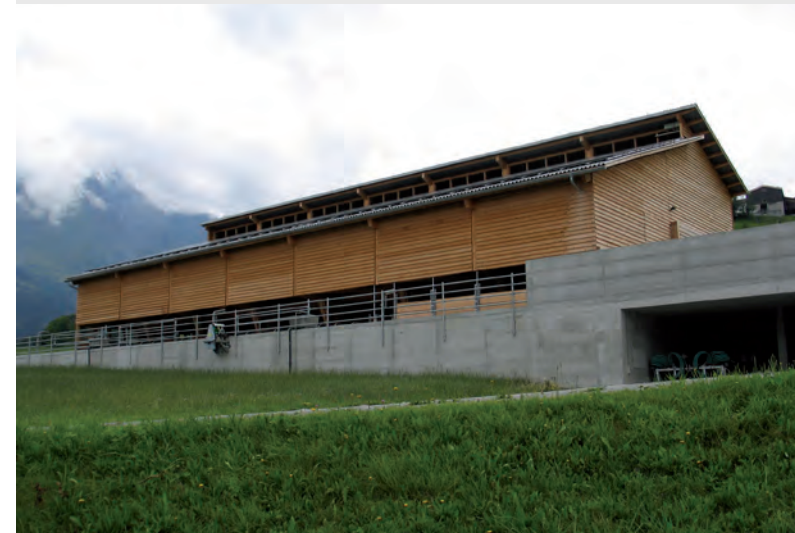
Urmein Bei diesem Stallgebäude wurde unbehandeltes Holz der Fassade mit Sichtbeton kombiniert. Die beiden Materialien ergeben ein reizvolles Zusammenspiel.
