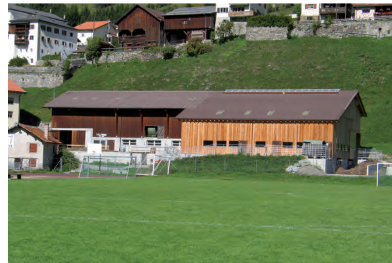
Tinizong-Rona Der bestehende Stall wurde um einen Anbau erweitert. Der neue Baukörper ist deutlich erkennbar. Die gleiche Dachneigung und Dacheindeckung verbindet die beiden Baukörper.
