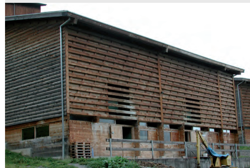
Vrin Die Bauten sind in ortsüblichen Materialien erstellt worden. Sockel und darüber liegendes Geschoss sind in Strickbauweise aus einheimischem Holz erstellt. Die Material- und Farbwahl entspricht der Bautradition, jedoch unterscheidet sich die Art der Holzkonstruktion von ihren traditionellen Vorgängern und lässt sie als neue Gebäude erkennen.
