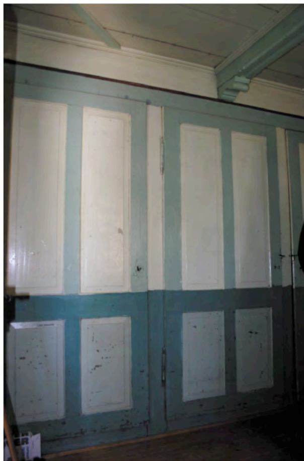
Abb. 399 : Einbauschränk mit Sockelbemalung & Detail Auflager Mittelbalken
