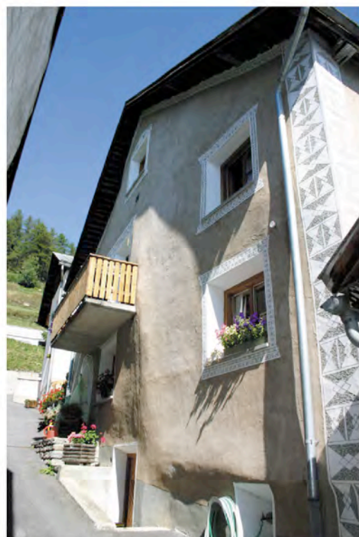
Abb.476 : Südwestfassade, gebauchte vorgemauerte Aussenwand
