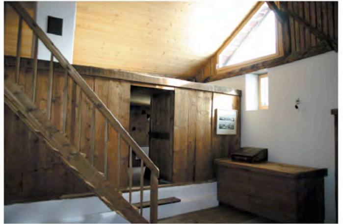
Abb.232 : Schlafkammer in Bohlenkonstruktion über Küche
