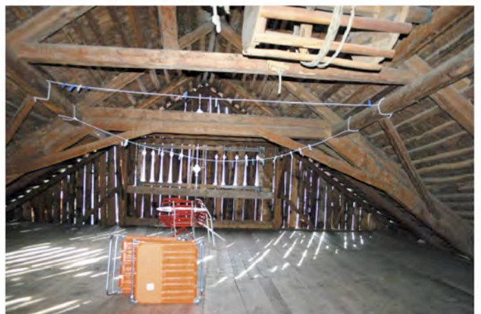
Abb.234: Charpanta: liegender Dachstuhl mit Spindel
