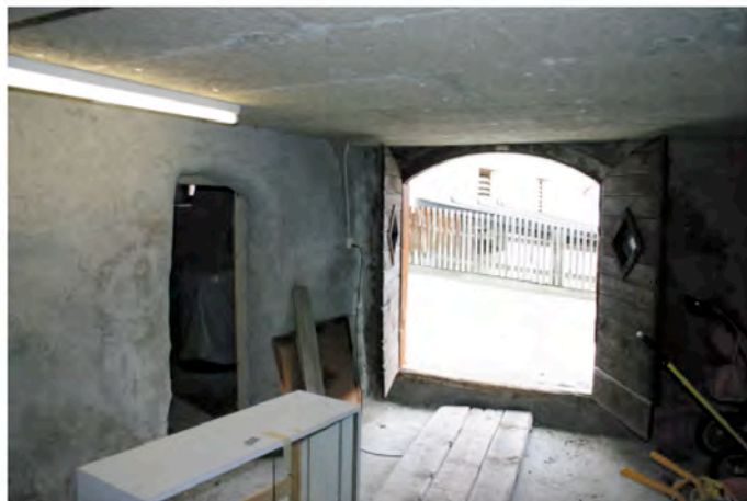
Abb. 590 : stichbogiger Cuorteingang. links der Keller
