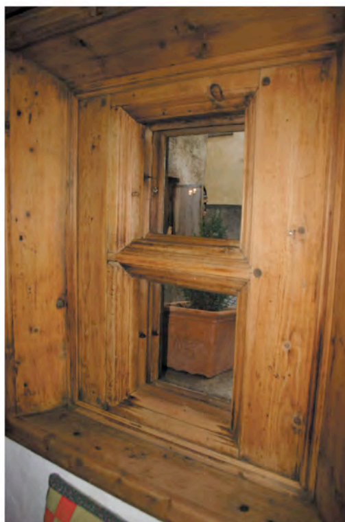
Abb. 259 : „Engadinerfenster“ im Piertan mit Schiebefensterchen
