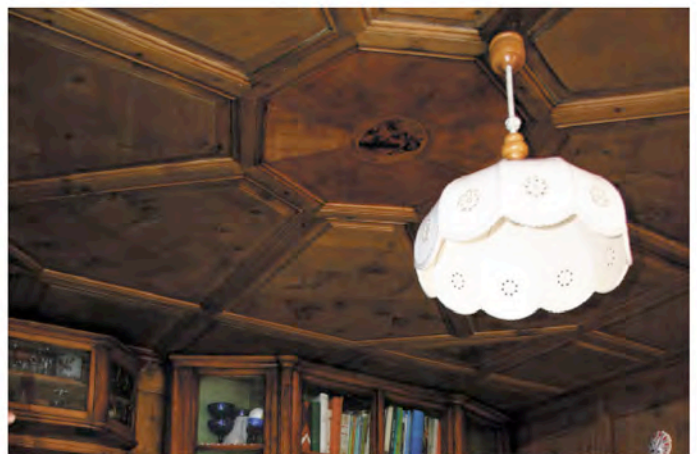
Abb. 23: Haus Nr. 39: Häufig in Tschlin anzutreffende Deckengestaltung um 1860: Felderdecke mit zentralem Deckenspiegel und Motiveinsatz
