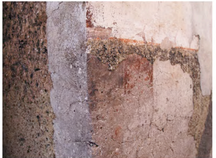
Abb. 79: Farb- und Verputzschichten
