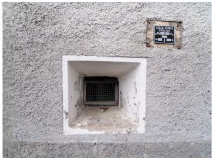
Abb. 99 : schartenförmiges Trichterfenster
