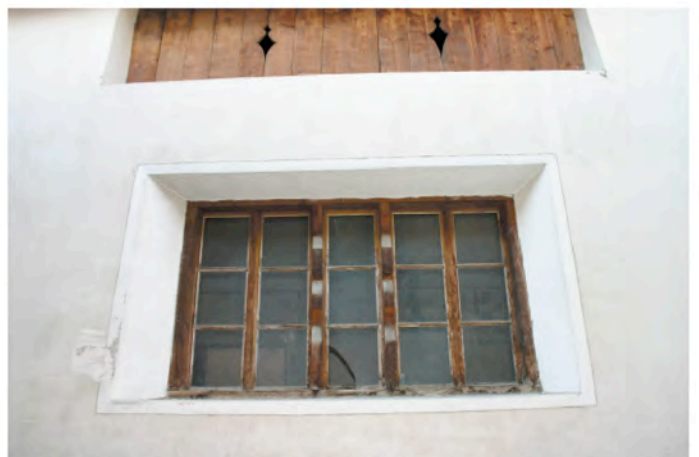
Abb. 584 : dreiteiliges (Werkstatt?-) Fenster mit zwei geschwungenen Setzhölzern
