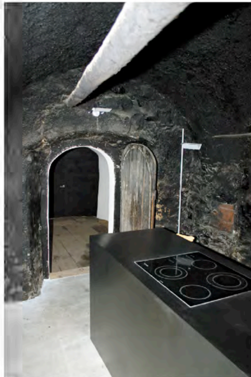
Abb. 24 : Haus Nr. 49: Russsschwarze Küche Aufhängevorrichtung für Fleischwaren. Feuerungslücke zum Stubenofen (rechts)
