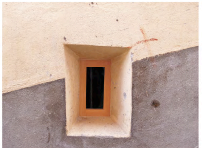
Abb. 201 : neuer Rahmen in mittelalterliche Scharte
