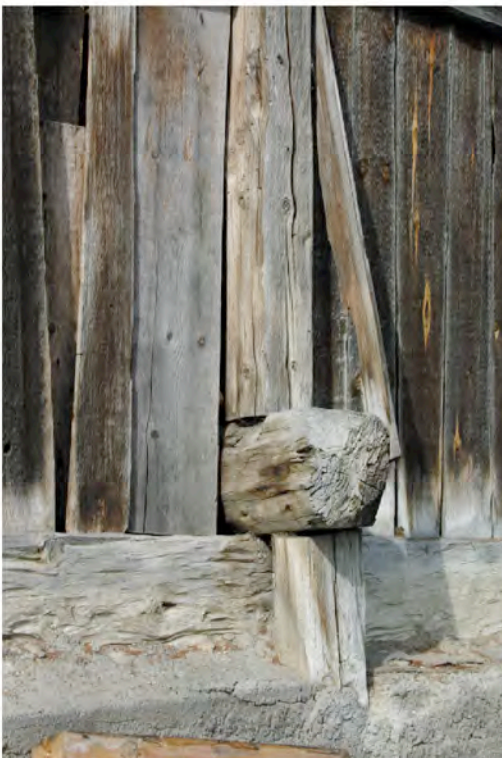
Abb. 26: Haus Nr. 58: Detail der äusseren Abstützung der Tennkonstruktion
