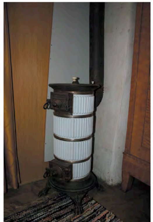
Abb. 421 : Zylinderofen mit weissen kannelierten Kacheln
