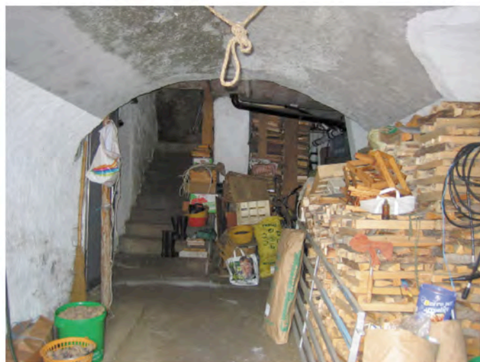
Abb. 645 : Cuort mit Flachtonne
