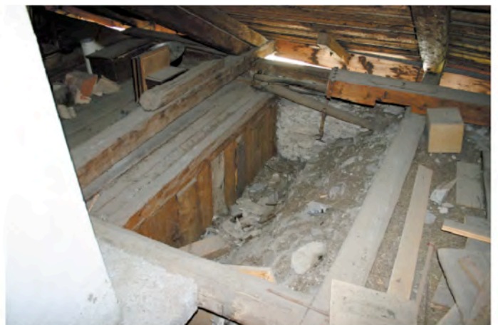
Abb.42 :Detail Gewölbe neben Bohlenkonstruktion
