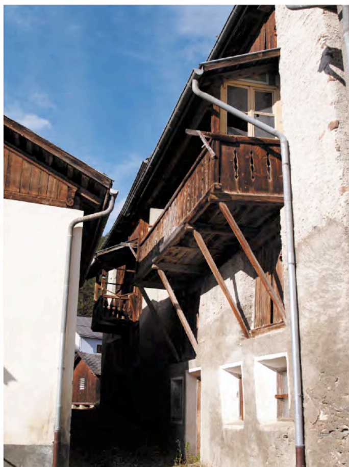
Abb. 83 : Laube auf Mittelpfeiler gelagert
