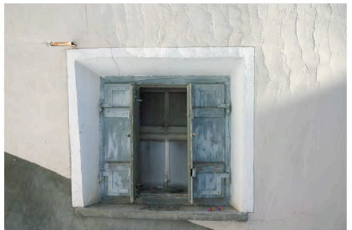
Abb. 583 : petrolgrüne, vierteilige Fensterladen aus Holz
