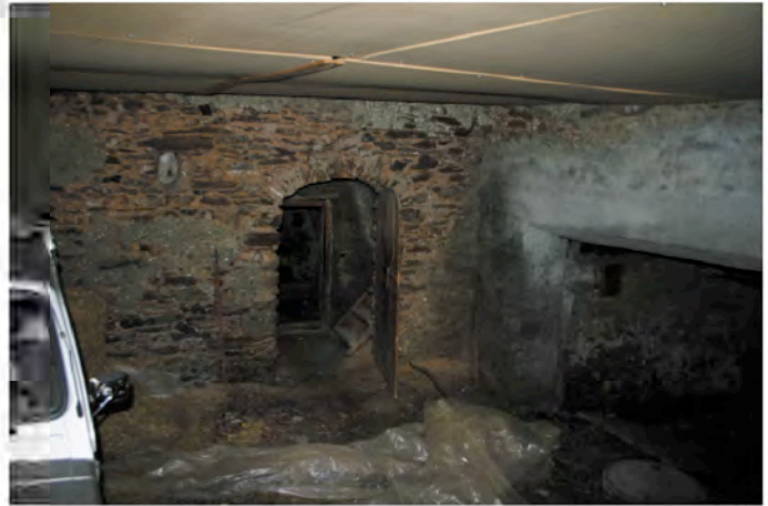
Abb. 119: Cuort mit stichbogigem Durchgang in Treppenhaus
