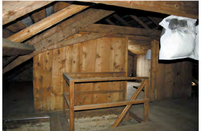
Abb. 31: Haus Nr. 49: einfache Knechtekammer in Bohlenkonstruktion unter einem liegenden Dachstuhl
