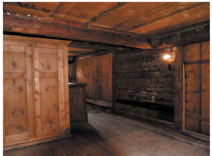
Abb. 246 :Palantschin; Chambras in Strickkonstruktion im Obergeschoss
