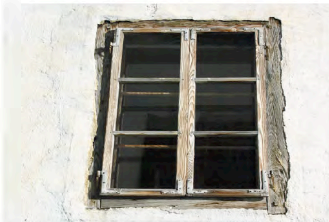
Abb 549: ursprüngliches Kastenfenster
