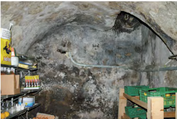
Abb.298 : Tonnengewölbe mit Kellerhals
