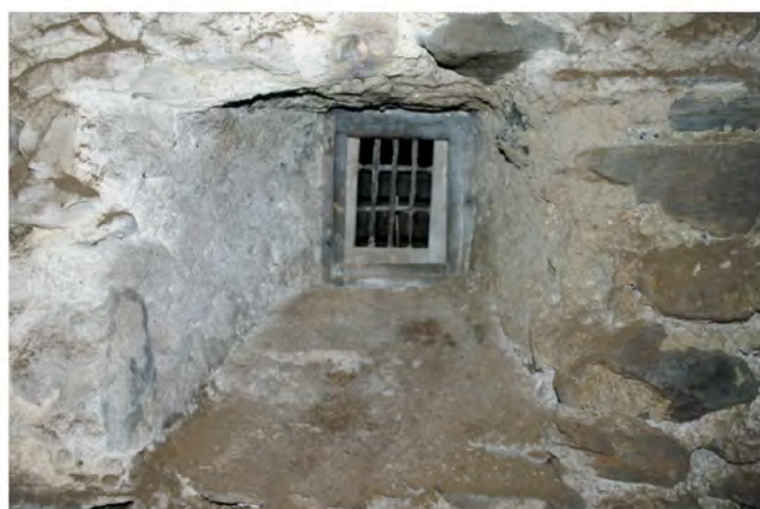
Abb. 110 : schartenförmiges Trichterfenster mit Gitter
