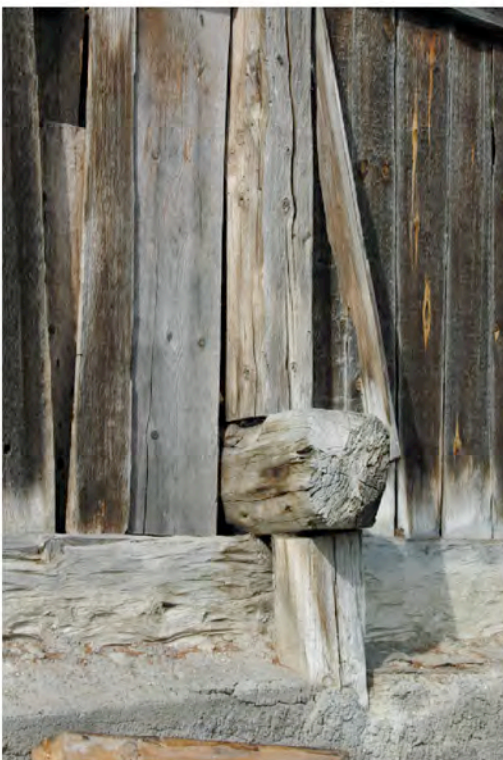
Abb.412 : Detail der äusseren Abstützung der Tennkonstruktion
