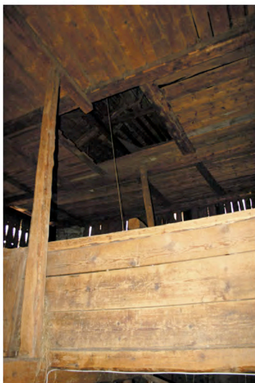
Abb. 331 : gänzlich erhaltenes Tenn mit Aufzug in die Charpainta
