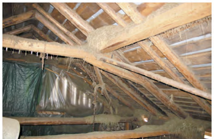
Abb. 33 Haus Nr. 59: Liegender Dachstuhl- das gängigste Konstruktionsprinzip
