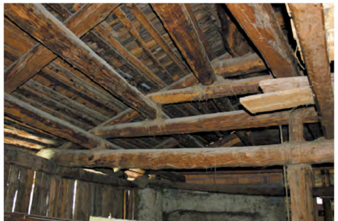
Abb. 32: Haus Nr. 58: Seltene Dachkonstruktion mit aufgetröhlten Balken im
