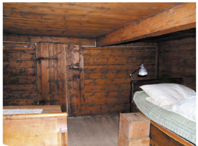
Abb. 247 :Chambra von Innen mit handgeschlagenem Mittelbalken
