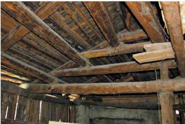
Abb.410 : aufgetrölte Dachkonstruktion
