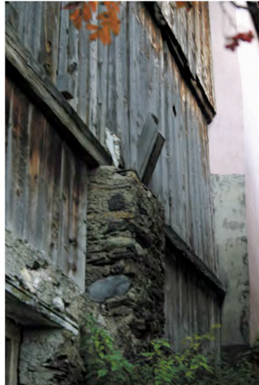
Abb. 27: Haus Nr. 35: Detail des auspuffähnlichen Belüftungskanal
