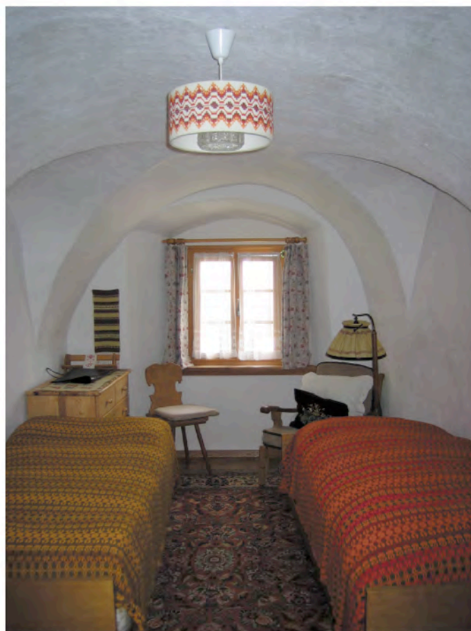
Abb. 644 : Zimmer über nördlichem Annex: Flachtonne mit Stichkappen
