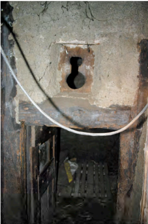
Abb.311 : Kellertüre mit schlüsselförmiger Scharfe über Sturz (Holzbrett mit Ausschnitt)
