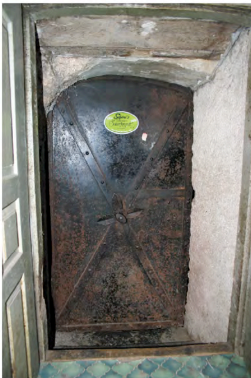
Abb.299 : Durchgang von Laden zu Keller mit Doppeltüre in Holz & Stahl
