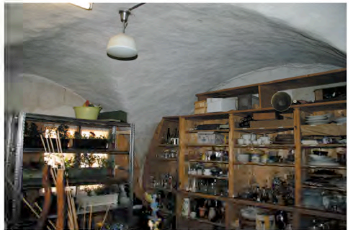
Abb. 304 : Südlicher Gewölberaum mit grossen Stichkappen
