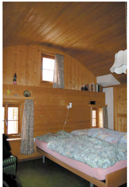
Abb.453 : Dachgeschoss mit neuinterpretiertem Tonnengewölbe
