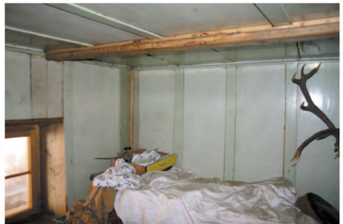
Abb. 59 : bemalte Chambra in Bohlenkonstruktion
