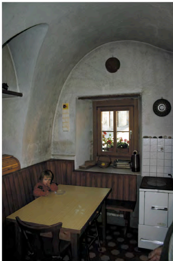
Abb. 159 : Küche mit abgestufter Stichkappe
