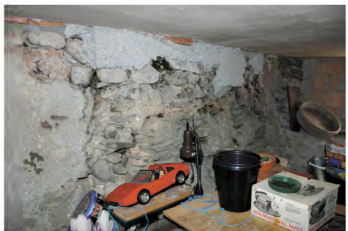
Abb. 431 : Bruchsteinmauer in einen ehemaligen Kellerraum
