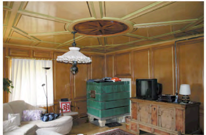
Abb. 96 :Stube mit oktogonaler Felderdecke
