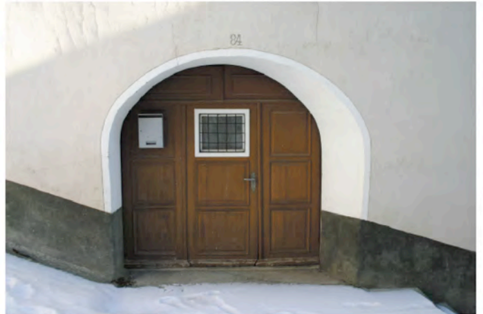
Abb. 582 : Piertaneingang mit asymmetrischer Leibung
