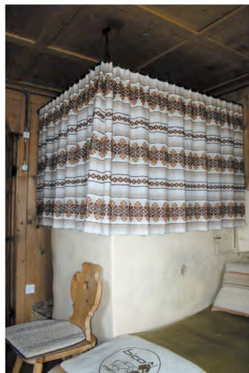
Abb. 382 : gemauerter Ofen mit stucco lustro*
