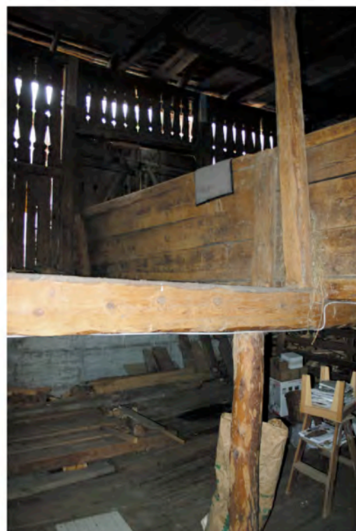
Abb. 28: Haus Nr. 45: Detail der inneren Abstützung der Tennkonstruktion
