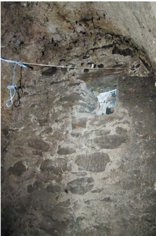
Abb.367 : Kellergewölbe unter der Spensa mit mittelalterlicher Fensterscharte
