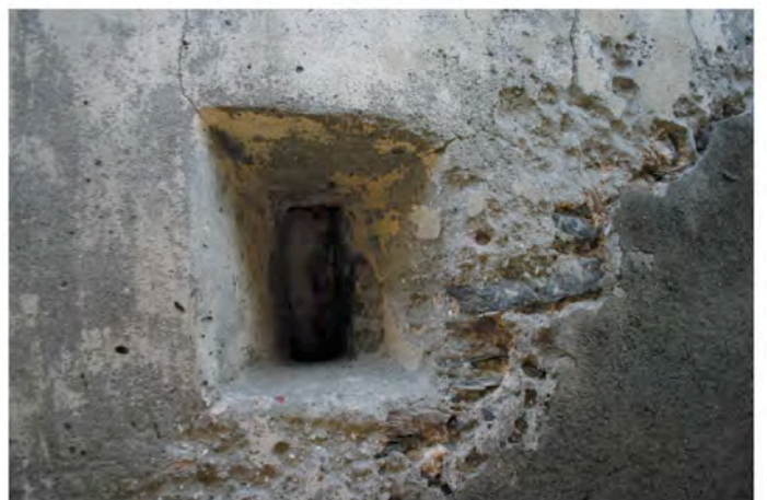
Abb. 349 : mittelalterliches Scharfenfenster im Untergeschoss
