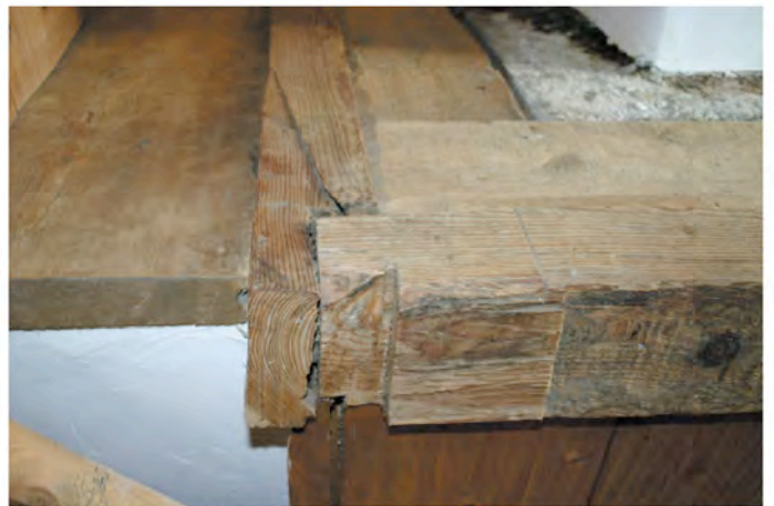
Abb.233 : Eckverbindung der Schlafkammer
