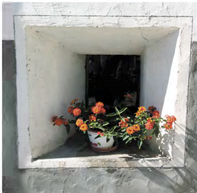
Abb. 152 : mittelalterlicher schartenförmiger Trichter
