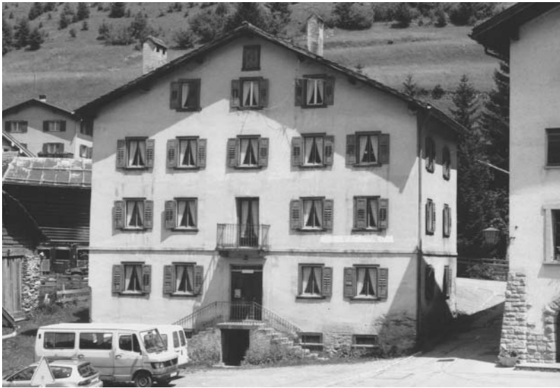
Abb. 32: Das stattliche Haus Nr. 87 im Zentrum von Tinizong wurde 1876 auf Grundmauern aus dem 14. Jh. neu gebaut.
