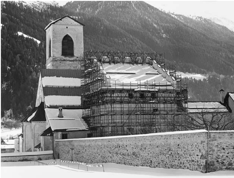
Abb. 3: Müstair 1997, Kloster St. Johann; Plantaturm mit Spezialgerüst und Sicherungsgurt im Winter 1997. Im Hintergrund die Klosterkirche.
