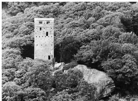
Abb. 53: Anlässlich der jüngsten Restaurierung 1997 wurde über der Torre Pala ein Schutzdach aus Stahl und Drahtglas erstellt.
