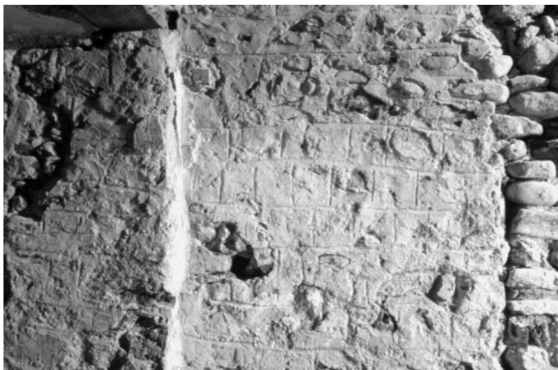
Abb. 105: Cazis, Kapelle St. Wendelin. Innere Südwestecke. Detail mit Fugenstrichverputz von ca. 1275.
