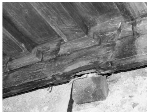
Abb. 76: Chur 1997/98, Kirchgasse 14 (Schniderzunft). Detail der spätgotischen Holzdecke nach der Freilegung, Zunfthaus, 1. OG.
