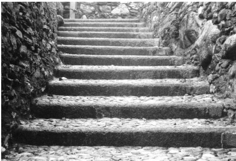
Abb. 98: Roveredo - Toveda, Treppenstufen mit Bollenpflästerung.
