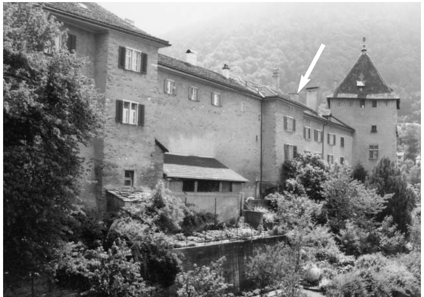
Abb. 66: Chur 1998/99, Hof 7. Das untersuchte Areal befindet sich im ersten turmartigen Teil in der Umfassungsmauer westlich des Treppenturms.
