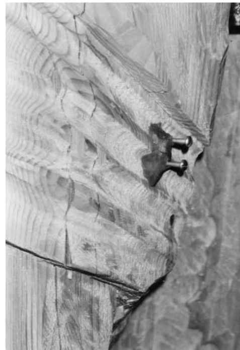
Abb. 132: Um die Feuchtigkeit im Innern des Holzes messen zu können, werden zwei Schrauben (je 12,5 cm lang) in die Rückseite der Figuren gedreht und an einen Stromkreis angeschlossen. Der so messbare elektrische Widerstand gibt Aufschluss über die gegenwärtige Holzfeuchtigkeit.
