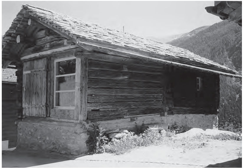
Abb. 135: Patzen, "La Caplutta". Südwestansicht.
