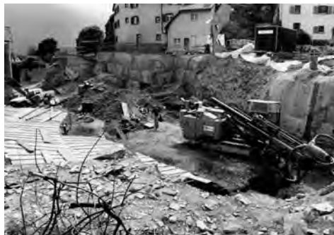
Abb. 21: Haldenstein, "Stein". Blick von Nordosten in die Baugrube. Das Plastikdach links schützt erste Ausgrabungen im prähistorischen Schichtenbereich.
