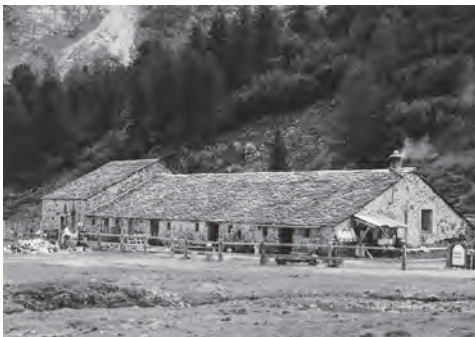
Abb. 155: Alp da Cavloc. Der um 1900 entstandene Norm-Alpstall. Ansicht von Westen.
