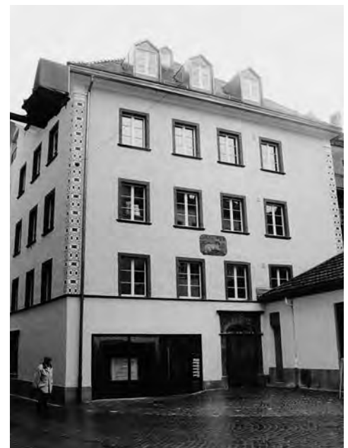
Abb. 63: Chur, Reichsgasse 49. Das Haus “zum Schäfli” nach dem Umbau 1999. Blick von Nordwesten.
