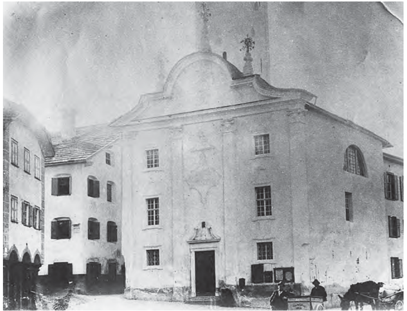
Abb. 107: Samedan, Dorfkirche Plaz. Diese Aufnahme von 1890 zeigt die klassizistische Fassung. Sie wurde bei der Restaurierung von 1965 für die Rekonstruktion der Detailformen der Eingangsfassade beigezogen.
