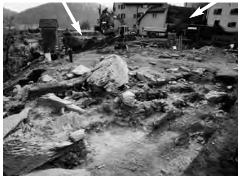
Abb. 20: Haldenstein, "Stein". Das Baugelände auf dem "Stein" von Nordosten, nach dem Abbruch der Gebäude 1998. Im Vordergrund die letzte Grabungsetappe des Friedhofs. Die Pfeile markieren Felsbrocken des Bergsturzes.
