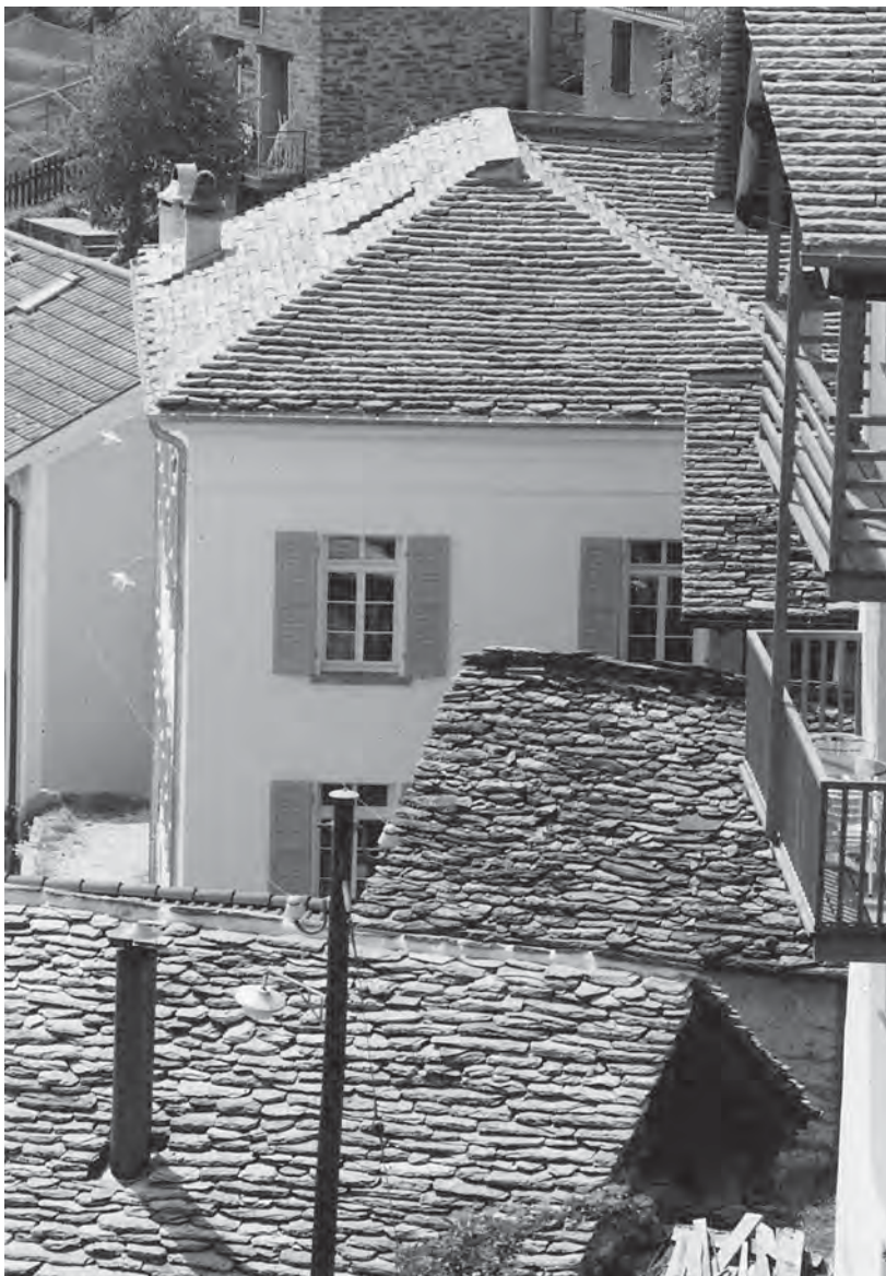
Abb. 136: Sta. Maria, altes Schulhaus. Dachlandschaft. Ansicht von Osten.
