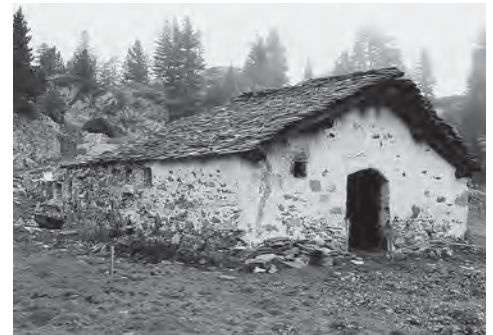
Abb. 152: Alp da Cavloc, Alte Sennerei. Ansicht von Südosten. Links oberhalb des Eingangstores ist das Rauchloch zu erkennen.
