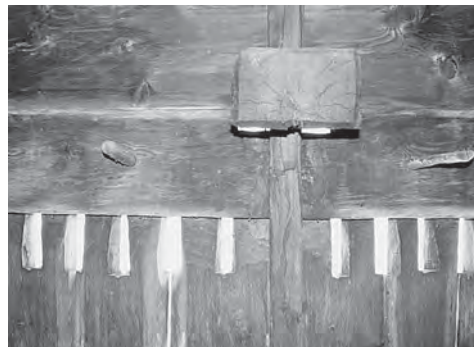
Abb. 159: Alpdörfer von Soazza. Die Luftschlitze in der Giebelfront der Höfe ermöglichen die kühle Lagerung von Butter und Milch.
