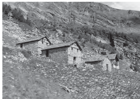
Abb. 164: Alp da Lughezzon. Die zwei vorderen Höfe mit bergseitigem Eingang zur cassina und talseitigem Stall- und Käsekeller-Eingang sind ganz in Trockenmauerwerk erstellt. Ansicht von Südosten.
