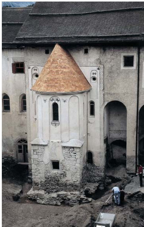
Abb. 9: Müstair, Kloster St. Johann. Nordhof: Frühmittelalterliche Ulrichs- und Niklauskapelle im barocken Kleid von 1626 nach der Restaurierung im Jahr 2000; Blick gegen Westen. Rechts unten ist noch die Kaminwärze des ehemaligen Ofenhauses und der späteren Hostienbäckerei zu sehen.
