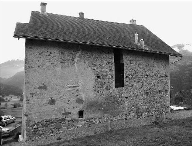
Abb. 135: Brienz/Brinzauls-Vazerol, Tgesa Gronda. Der neue Zugang von Norden in die Wohnung des zweiten Geschosses. Als Material wurde Eisen gewählt, um den Eingriff in die historische Substanz lesbar zu machen. Die den Eingang erschliessende Aussentreppe fehlt noch.
