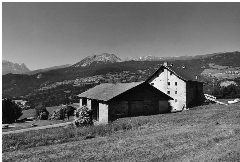
Abb. 131: Brienz/Brinzauls-Vazerol, Tgesa Gronda. Der Hof von Osten.
