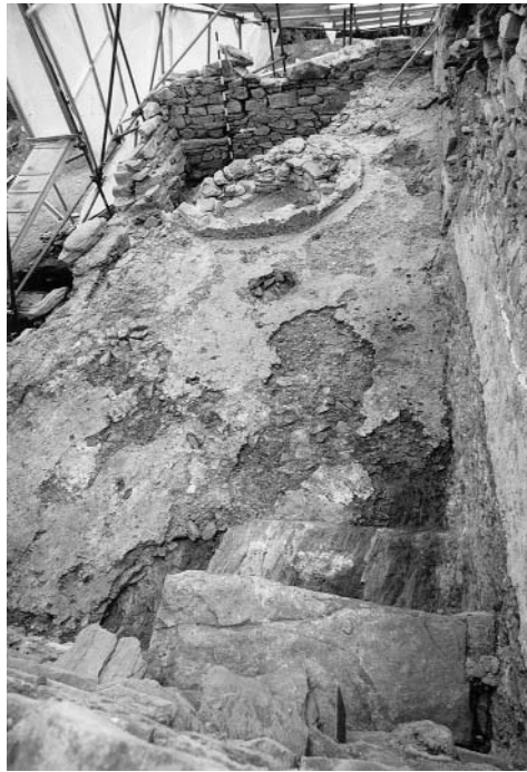
Abb. 18: Sils i.D., Burganlage Hohenrätien. Der Innenraum des Baptisteriums von Westen.
