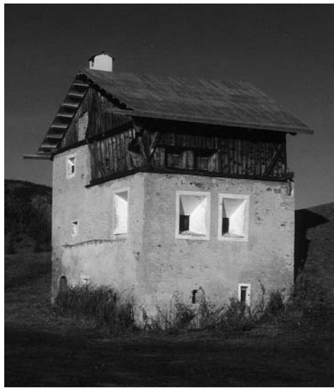
Abb. 106: Zuoz, Chasté Sur En Nr. 152. Neues Brettschindeldach. Ansicht von Westen.
