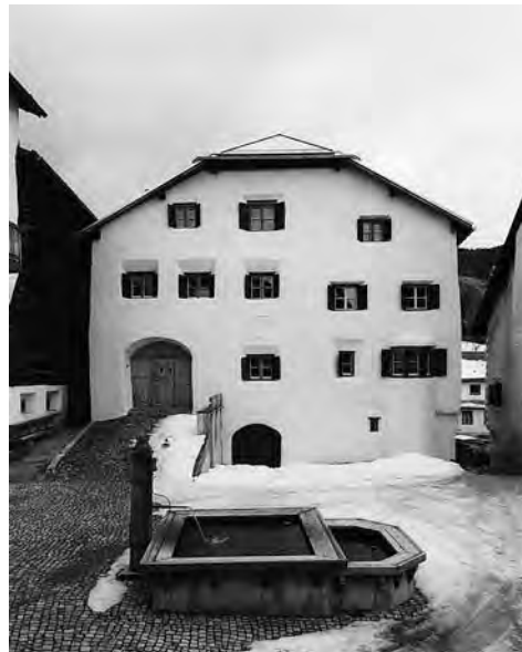
Abb. 250: Ardez, Haus Nr. 69. Platzfassade.
