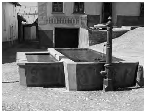
Abb. 264: Tschlin, Aussenräume. Die Brunnenröge aus Beton von 1905 haben durch die Restaurierung den ursprünglichen Charakter zurückerhalten. Der Brunnenstock dient gleichzeitig als Hydrant.
