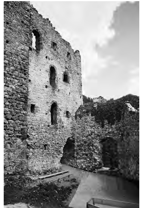
Abb. 203: Brienz/Brinzauls, Burgruine Belfort. Der Torturm (Phase 2), Südfassade. Ansicht von Süd- westen.
