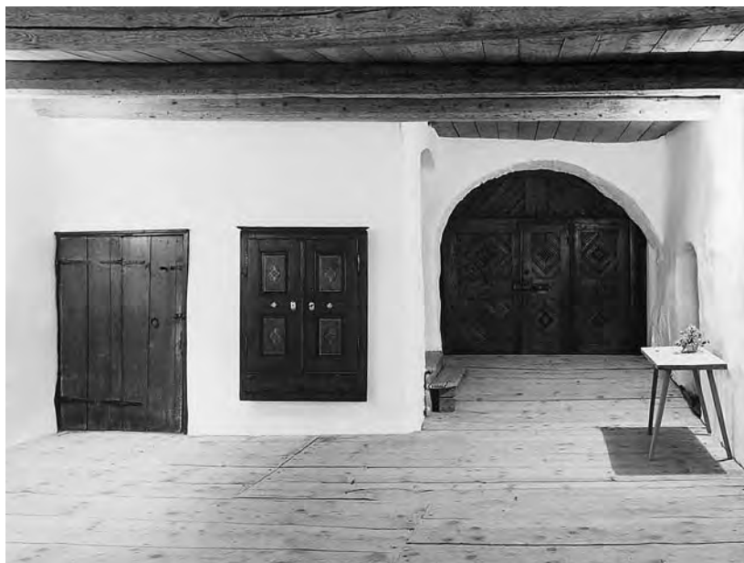
Abb. 256: Ardez, Haus Nr. 69. Der "Piertan" (Durchfahrt zum Heustall). Der Raum wurde nur instandgestellt und blieb so original erhalten. Auf Heizkörper wurde bewusst verzichtet. Temperiert wird der Raum durch im Aussenwandverputz verlegte Heizrohre.
