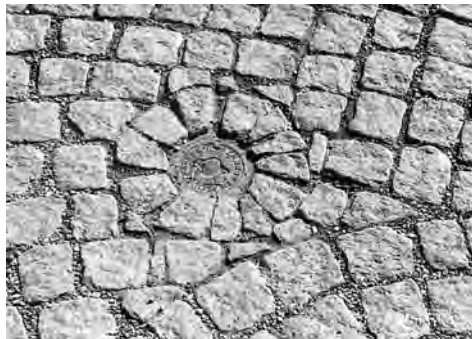
Abb. 171: Andeer, Detail der neuen Strassenpflasterung.
