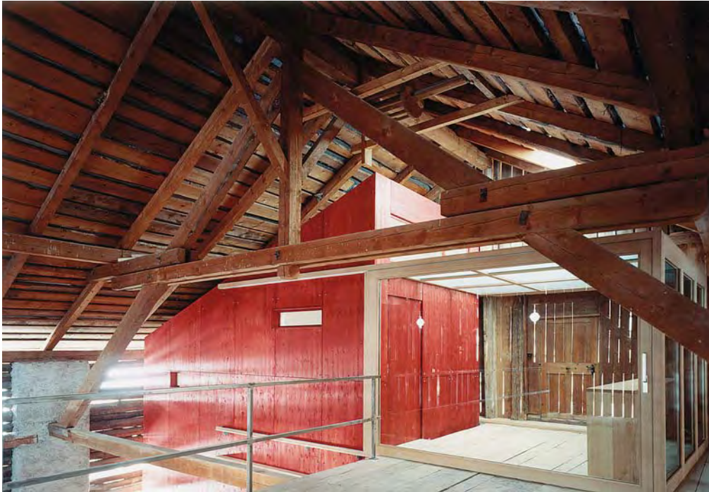
Abb. 254: Ardez, Haus Nr. 69. Das oberste Heustallge- schoss mit Blick auf den neu eingebauten „Turm“, wo die Heizung und die Sanitätsräu- me untergebracht sind. Klei- ne Öffnungen lassen gezielt Licht hinein oder sorgen für spannende Ausblicke.
