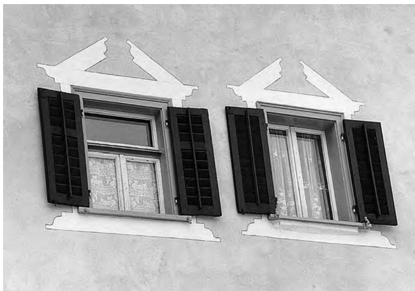
Abb. 170: Sumvitg, Casa Crap Nr. 39. Detail der restaurierten Fassade.
