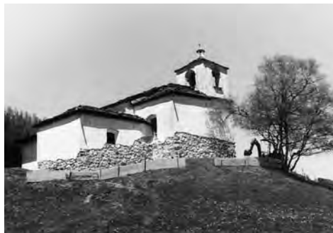
Abb. 134: Riom-Parsonz, Kapelle St. Bartholomäus. Kapelle während der Renovationsarbeiten. Blick von Südosten.
