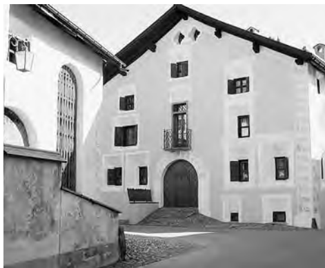
Abb. 235: Bever, Haus Cantieni Nr. 22. Zustand nach der Restaurierung. Man beachte die vier zu einer Gesamtform zusammengefassten Trichterfenster.
