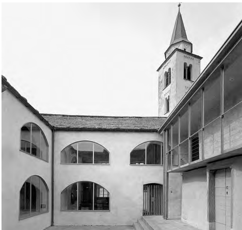
Abb. 221: Sta. Maria i. C., Pfarrhaus. Innenhof.
