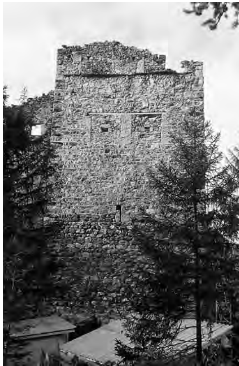
Abb. 201: Brienz/Brinzauls, Burgruine Belfort. Der Haupt- turm auf Belfort (Phase 1). Ansicht von Norden.
