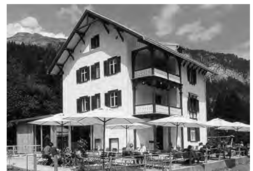
Abb. 237: Flims, Restaurant Pension Crestasee. Ansicht aus Südwesten.
