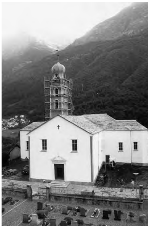
Abb. 130: Mesocco, Kirche San Pietro. Kirche während der Renovationsarbeiten. Blick von Westen.
