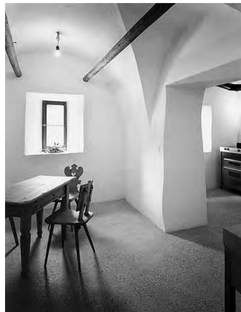
Abb. 257: Ardez, Haus Nr. 69. Die sehr kleine Küche wurde mit der Spense verbunden.
