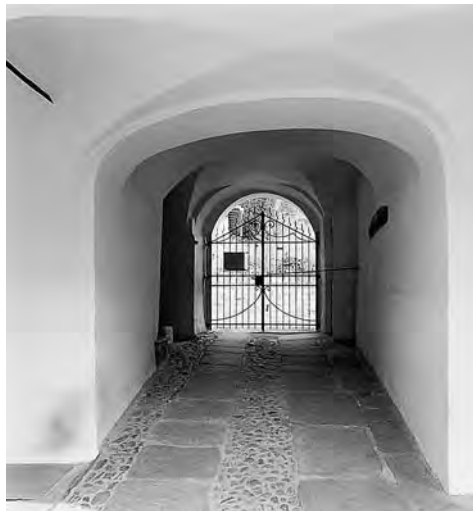
Abb. 229: San Vittore, Ca' del Gerb. Die Durchfahrt im Erdgeschoss.
