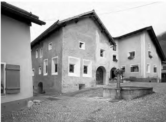
Abb. 243: S-chanf, Haus Nr. 120. Platzfassade. Um die Fassade zum „Leben“ zu erwecken, wurden die Trichterfenster neu verputzt. Die feinen Holzarbeiten der Stabwerkfenster aus dem 17. Jahrhundert wurden fachgerecht repariert.
