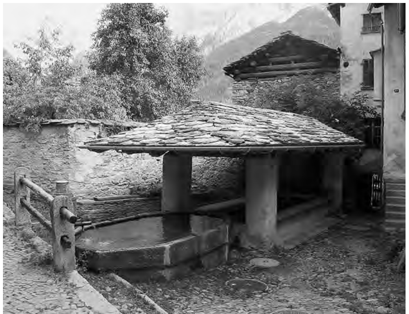
Abb. 239: Soglio, Fontana Piela. Nachzustand. Ansicht von Nordwesten.
