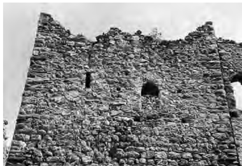
Abb. 202: Brienz/Brinzauls, Burgruine Belfort. Der Hoch- eingang an der Südfassade des Hauptturmes. Ansicht von Süden.
