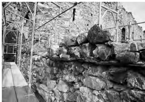
Abb. 213: Brienz/Brinzauls, Burgruine Belfort. West-fassade, vorkragender Stein-plattenkranz in der jüngsten Aufhöhung. Ansicht von Südwesten.
