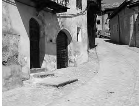
Abb. 262: Tschlin, Aussenräume. Drei grosse steinerne Stufen markieren den Übergang zwischen öffentlichem Strassenraum und privatem Innenraum.
