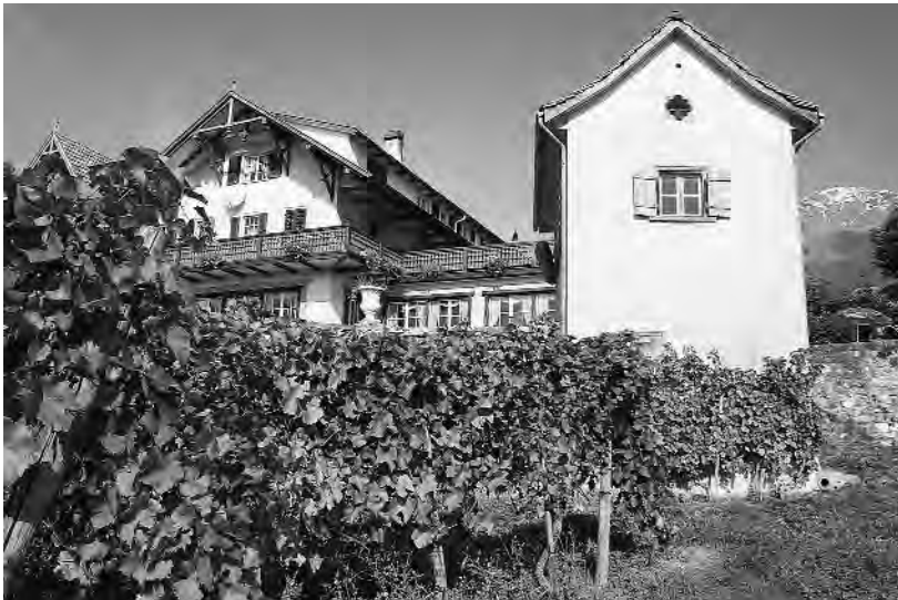
Abb. 165: Jenins, Rebhaus Nr. 62. Ansicht von Westen.
