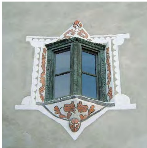
Abb. 109: Scuol, Haus Nr. 82. Details der restaurierten Fassade.
