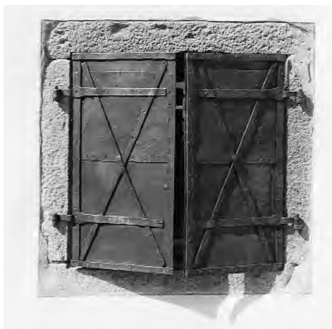
Abb. 168: Cazis, Haus Pajarola. Fenster des Vorratsraums mit restaurierten Metallläden.
