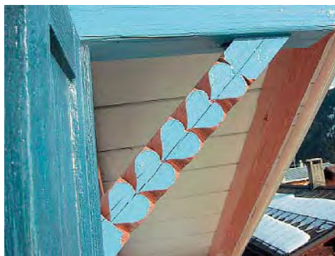
Abb. 105: Lumbrin, Cas'aulta Nr. 120. Detail Dachpfette.
