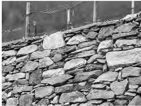
Abb. 106: Verdabbio, restaurierte Trockenmauer.
