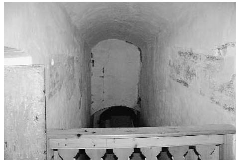
Abb. 9: Müstair, Kloster St. Johann. Westtrakt, Treppenschacht. Romanische Mäander unter der ehemaligen Decke, darüber eine barocke Gewölbetonne. Im Hintergrund: An der Süd- wand zeichnet sich der Umriss eines frühromanischen Rundbogenfensters ab. Blick gegen Süden.
