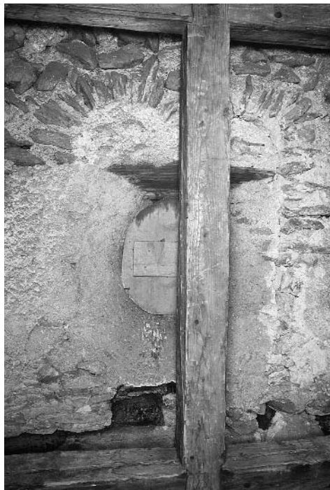
Abb. 7: Müstair, Kloster St. Johann. Kirche, Dachraum. Im Hochmittelalter wurde zusammen mit der Giebelaufrhöhung eine Bifore oberhalb des verkohlten karolingischen Balkens eingebaut. Der aktuelle Oculus entstand beim Dachneubau um 1517. Blick gegen Osten.
