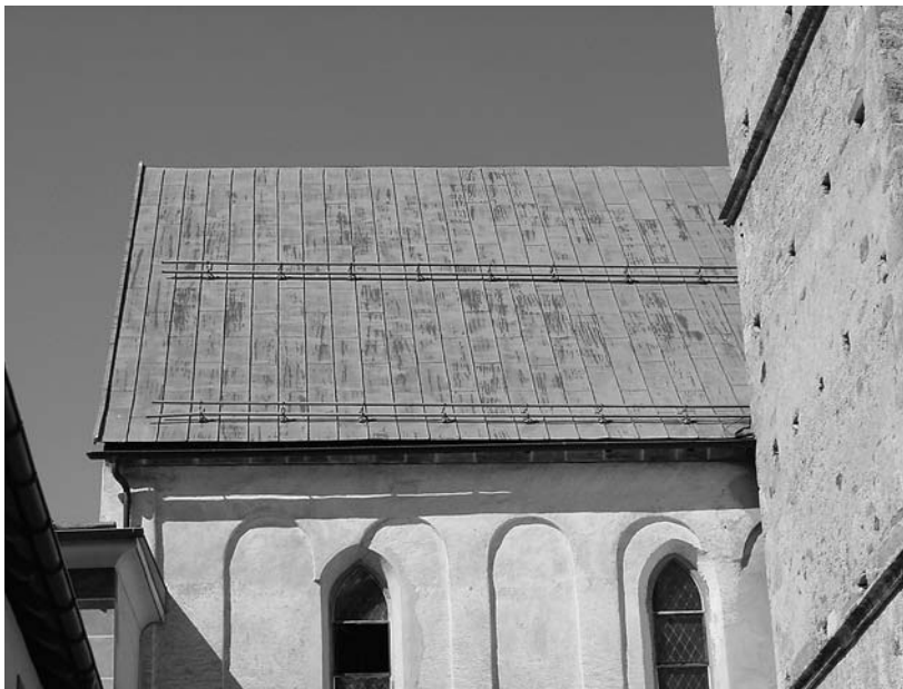
Abb. 66: Müstair, Kloster St. Johann, Klosterkirche. Das ungefähr 80 Jahre alte Dach aus verzinktem Eisenblech.
