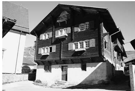
Abb. 154: Gebäudeinventar. Lumbrin, Haus Nr. 111. Südfassade.
