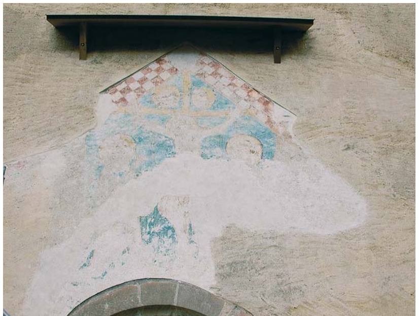
Abb. 80: Chur, Kathedrale St. Mariä Himmelfahrt, Altarhaus, Ostwand. Kreuzigungsdarstellung nach der Konservierung und Restaurierung. Zustand 2005.
