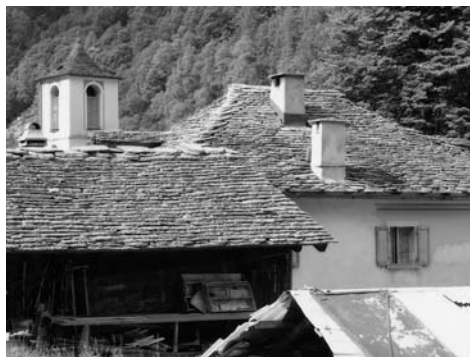
Abb. 111: Rossa, Augio. Das bäuerliche Gebäude im Vordergrund trägt ein Satteldach, das Bürgerhaus dahinter ein Walmdach und der Kirchturm ein Pyramidendach.
