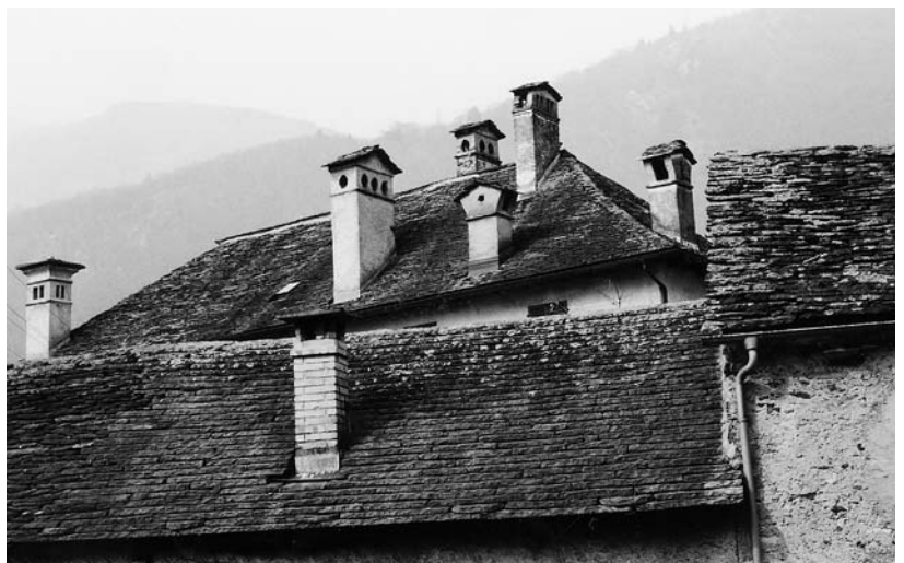
Abb. 119: Roveredo, Haus Toveda. Steinernes Walmdach mit Kaminen.
