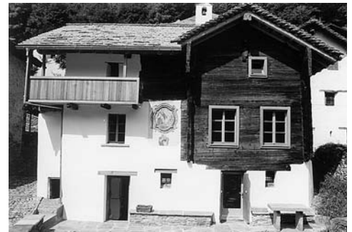
Abb. 63: Soazza, Casa San Floriano Nr. 111. Restaurierte Hauptfassade.
