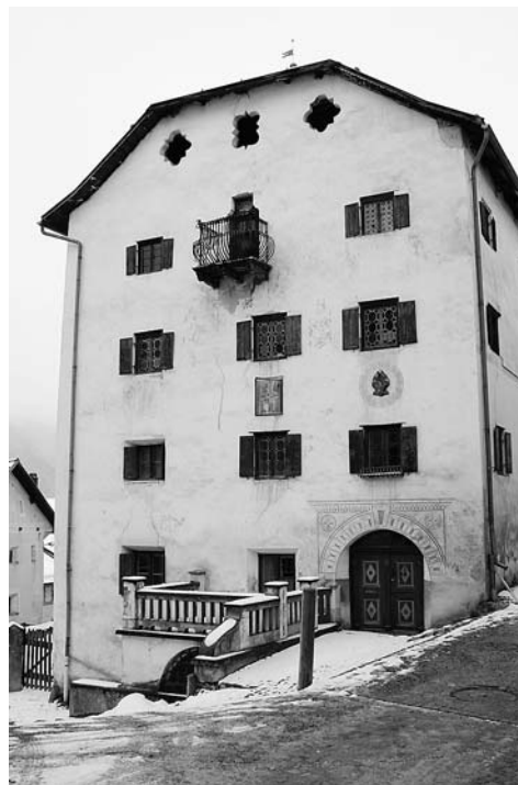
Abb. 155: Gebäudeinventar. Ardez, Haus Nr. 120. Ost- fassade.
