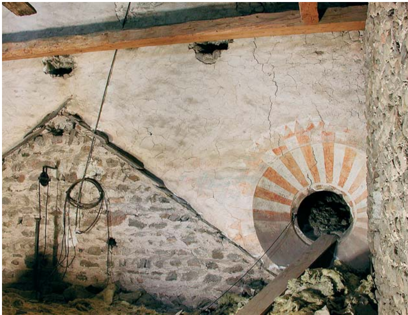
Abb. 73: Chur, Kathedrale St. Mariä Himmelfahrt. Dachraum über dem Altarhaus. Blick auf die Ostwand des Presbyteriums. Links ist die ursprüngliche Dachlinie des Altarhauses, rechts ein aussen ehemals sichtbares Rundfenster (Oculus) des Kirchenschiffes zu erkennen.
