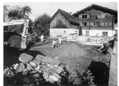
Abb. 44: Grüsch, Parzelle Nr. 159. Mit dem Bagger wird nach den Grundmauern des abgegangenen Gebäudes gesucht. Blick gegen Westen.
