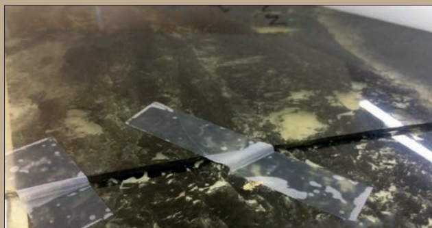
Mit Klebestreifen fixierte Bruchstelle
