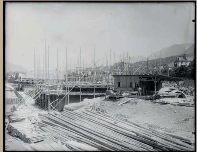
Chur, Baustelle Quaderschulhaus (ca. 1913) StAGR FN IV 24/30 C 081
