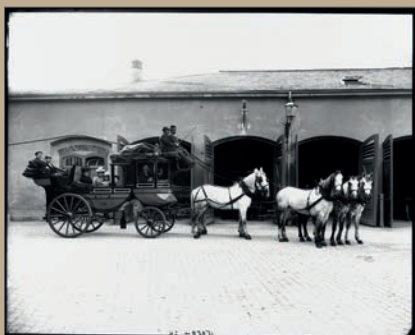
Postkutsche aufgenommen vor der Postremise in Chur
