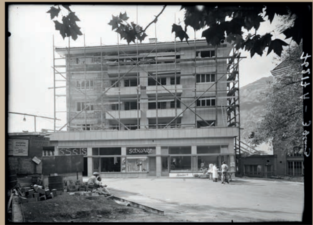
Chur, Baustelle Bahnhofstrasse 20, Haus Merz (ca. 1953) StAGR FN IV 13/18 C 092
