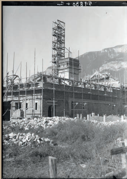
Chur, Baustelle Erlöserkirche (1934) StAGR FN IV 13/18 C 117
