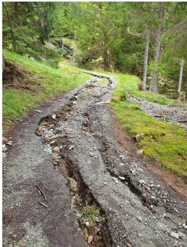
Abbildung 1 und 2: Erhebliche Erosionsschäden
