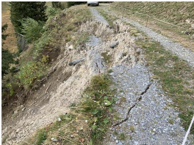
Abbildung 1: Talseitige Rutschung mit ersichtlichem Durchlassrohr
