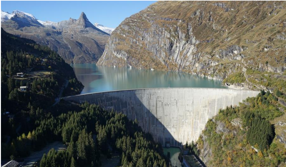
Bild: Stauanlage Zervreila, Kraftwerke Zervreila AG
