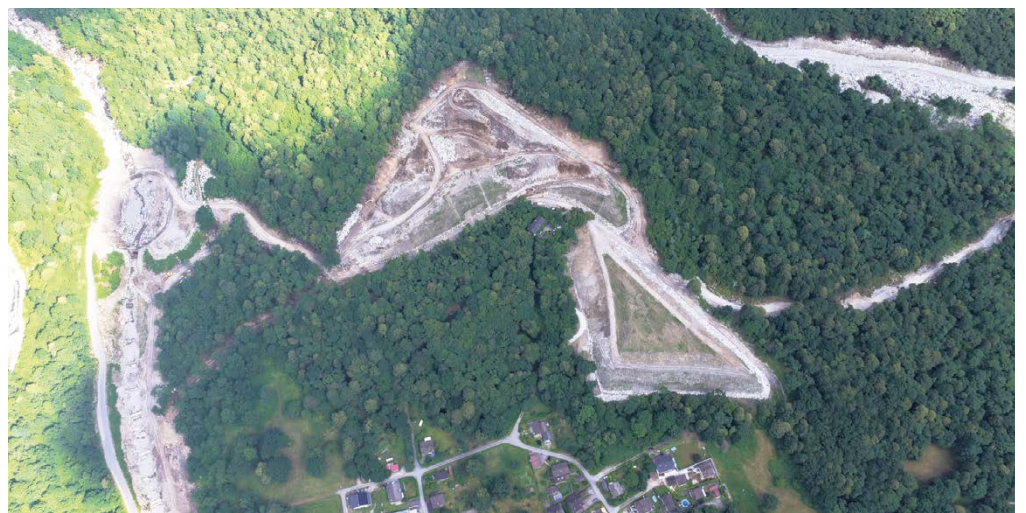
Die Deponie mit Kapazitäten für 300'000 m 3 Material bildet gleichzeitig einen Schutzdamm für Sorte. (Quelle: AWN, 2025)
