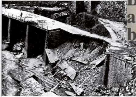
Zerstörte Talstrasse im Misox ©Freiburger Nachrichten 15.11.1980
