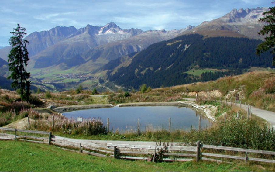
Abb 4 Der Löschwasserteich Stagias in der Gemeinde Medel wurde im Jahr 2001 zum Schutz der umfangreichen Vivian-Wiederaufforstungsflächen erbaut.
