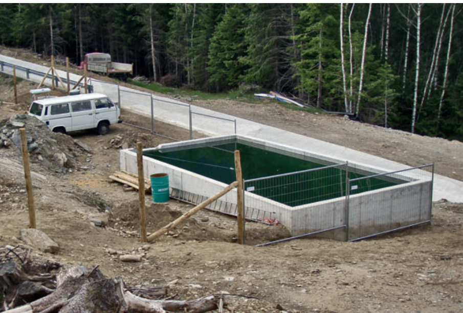
Abb 5 Das Löschwasserbecken Cramegn in der Gemeinde Soazza wurde im Jahr 2008 erbaut. Foto: L. Plozza
