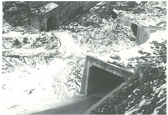
Das Tunnelportal von 1935 und die Galerie von 1953 im Tobelgrund
