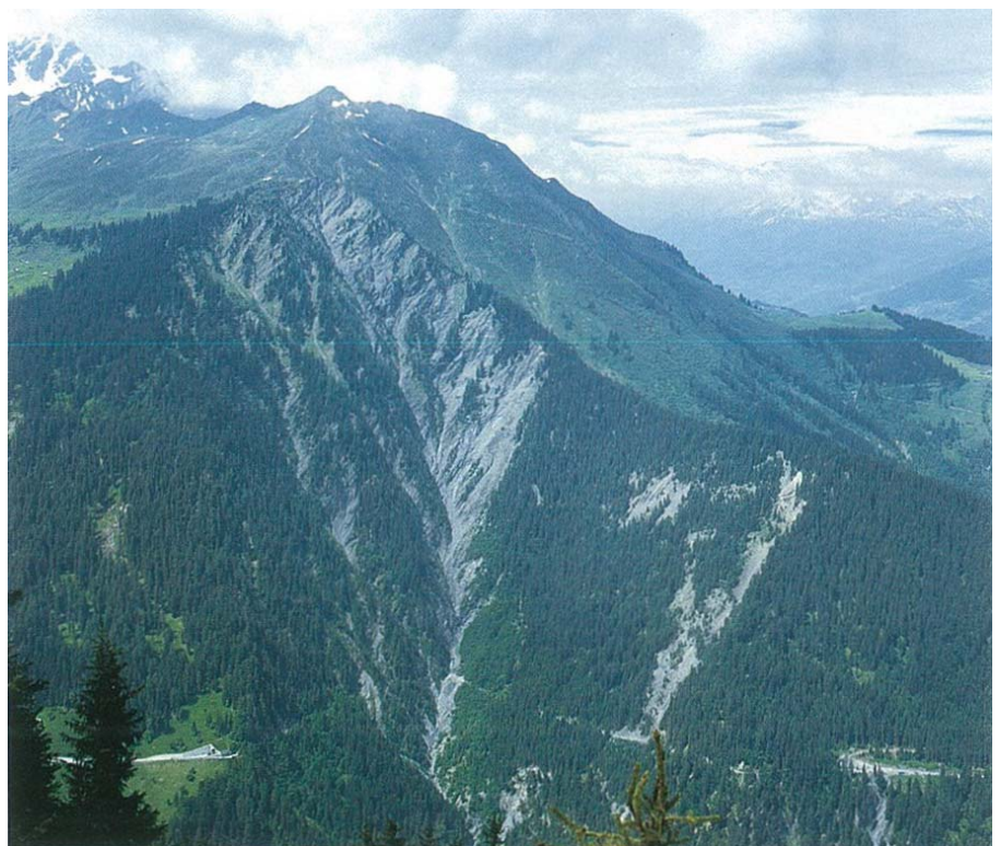
Das Aclatobel mit der alten Safienstrasse und den zwei neuen Tunnelportalen
