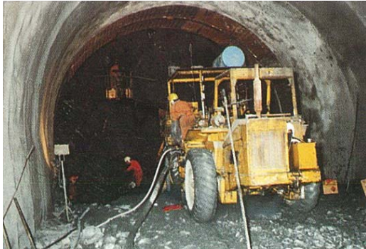
Die Mineure beim laden der Bohrlöcher
