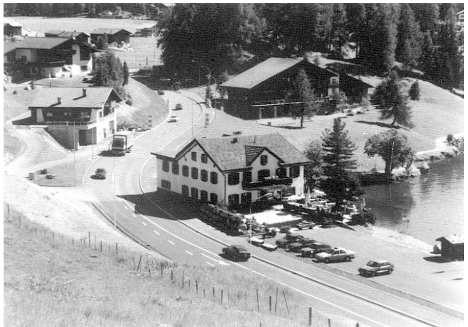
Die fertig ausgebaute Prättigauerstrasse am Davosersee
