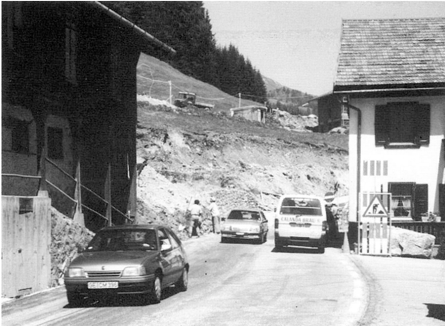
Der Engpass beim Hotel Seehorn, im Hintergrund der Abtrag der bergseitigen Böschung für die Verlegung der Prättigauerstrasse
