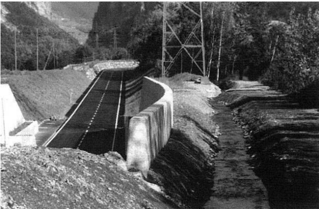
Der Kolmatierungskanal entlang dem Wuhrweg, links in Tieflage die neue Prättigauerstrasse
