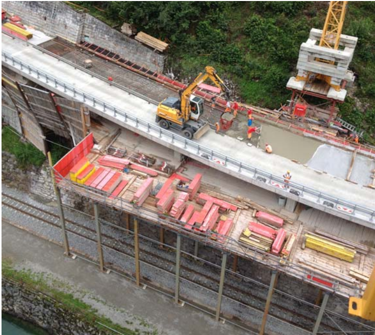
Sistemazione complessa della strada del Bernina tra il lago, i binari della Ferrovia retica e il ripido fianco della montagna.
