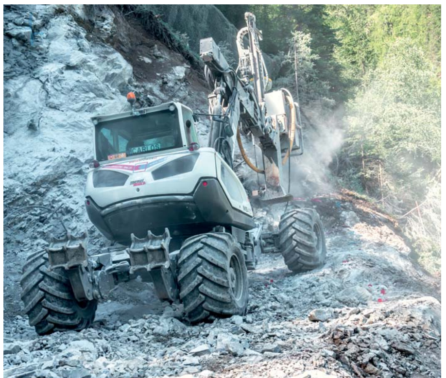
Bauarbeiten für den Voreinschnitt am Südportal
