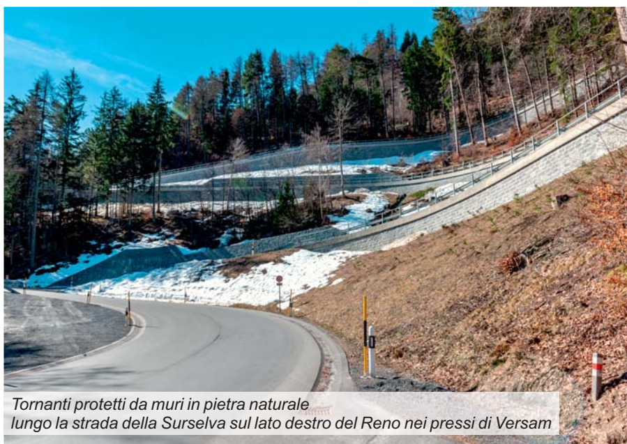
Muri in pietra naturale lungo la strada dell'Engadina presso Lavin
