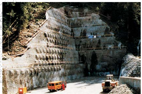
Voreinschnitt Drostobel bereit zur Startsprennung für den Gotschnatunnel
