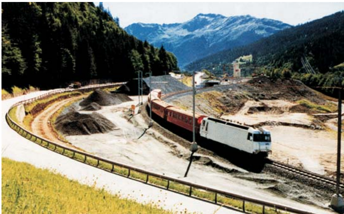
Das neuverlegte RhB-Trasse auf der Schüttung Büel
