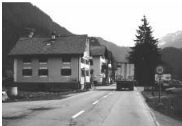
Rona innerorts vor der Sanierung: stark beschädigter Belag wegen ungenügender Foundationstiefe und fehlende Gehwege
