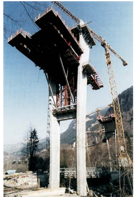
Pfeiler 4 mit Vorbauwagen
