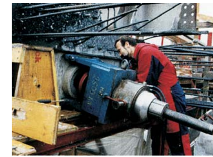
Spannen der Schrägseile mit einer hydraulischen Presse
