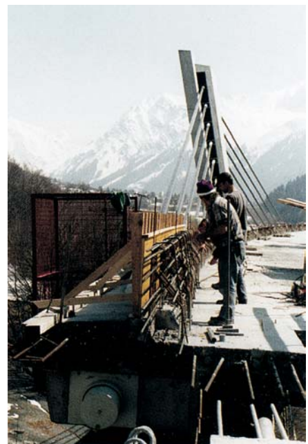
Randträger mit Abspannstelle Schrägseil und Armieren der Brüstung
