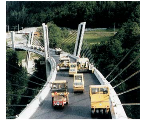
Belageeinbau auf der fertigen Brücke
