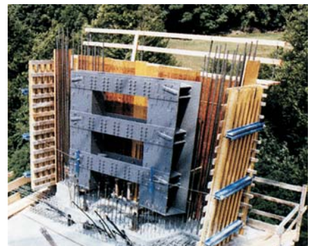
Stahlkonstruktion für Seilverankerung in der Pylonschalung
