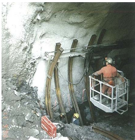
Sicherungsarbeiten im Tunnel Sax
