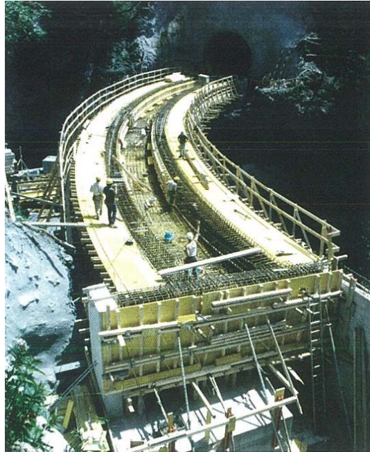
Schalung der Scheidnerbachbrücke
