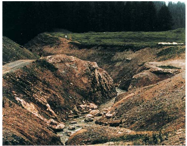
Der verlegte Stützbach windet sich heute in einem 10 bis 20 m tiefen Einschnitt durch das Selfrangaplateau.
