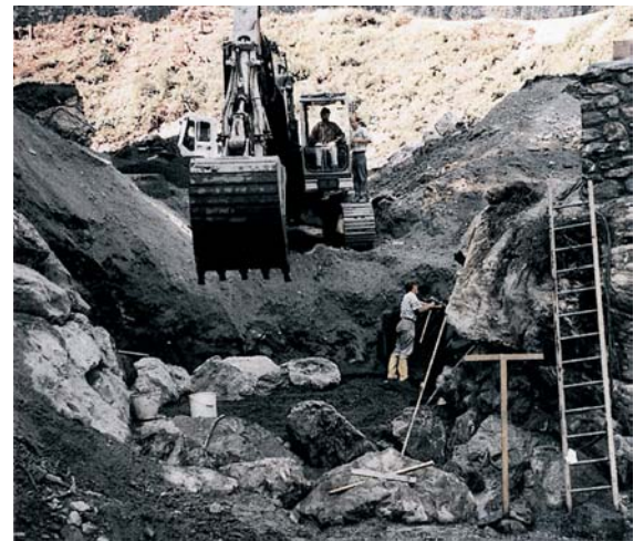
Der Steilbereich im Bau
