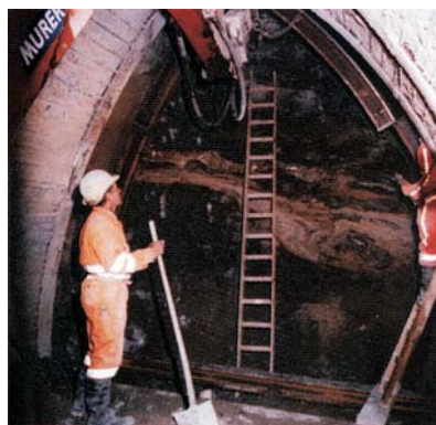
Einbau der Stahlprofile an der Brust des linken Ulmen-Firststollens
