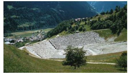
Auffangdamm zum Schutz von Trun und der Oberalpstrasse
