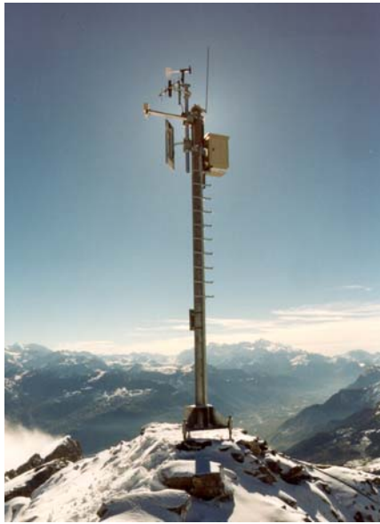
Windstation einer IMIS-Anlage
