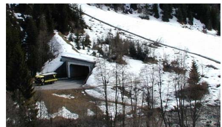
Tunnel Rotsch an der Landwasserstrasse unter einer Lawinensturzbahn
