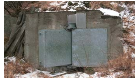
Auslöseklappe im Val Lumpegna für die automatische Sperre der Oberalpstrasse
