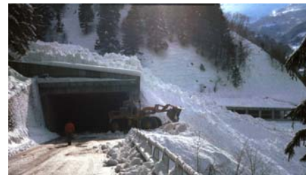
Galerie zum Schutz der Berninastrasse im Val Urezza
