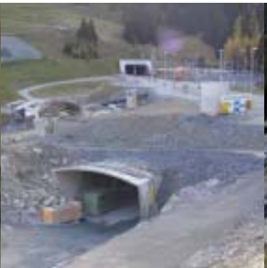
Portal Selfranga mit Lüftungskamin
