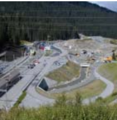
Bahnhof Selfranga mit verlegtem Stützbach
