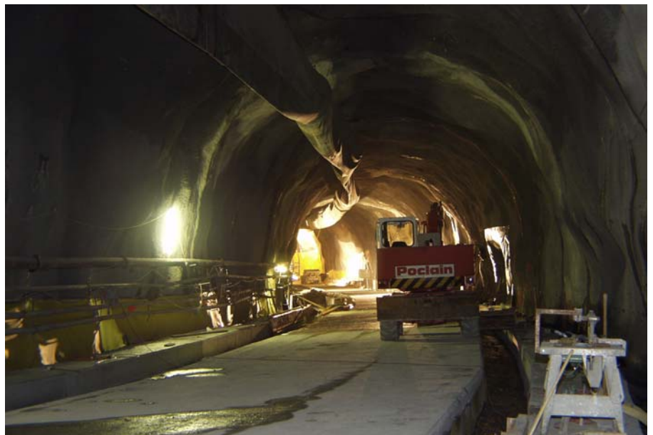
Der Tunnel im Rohbauzustand
