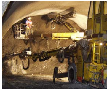
Bohren der Sprenglöcher an der Kalottenbrust
