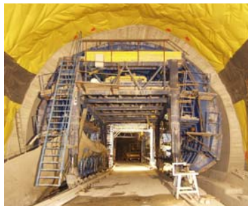
Abdichtung mit ausgeschalttem Innengewölbe
