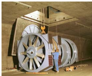
Montage eines Ventilators
