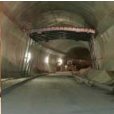
Fertigbetonierter Innenring mit Schalung für Zwischendecke
