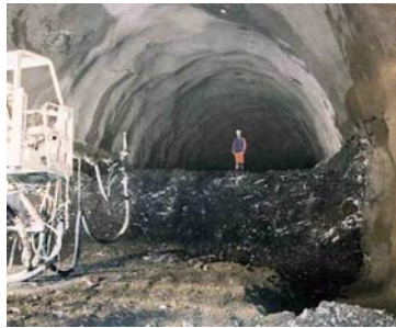
Sichern der Strossenabschläge
