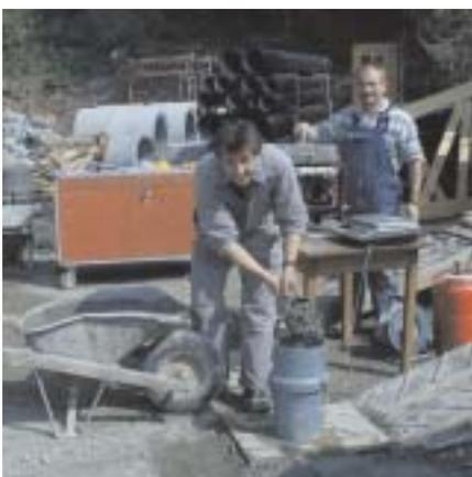
Konsequente Frischbetonkontrollen verhindern, dass ungenügender Beton ins Bauwerk gelangt.
