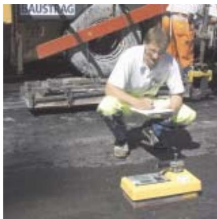
Prüfung der vorgeschriebenen Verdichtung des Asphaltbelages mit der Isotensonde direkt nach dem Walzen
