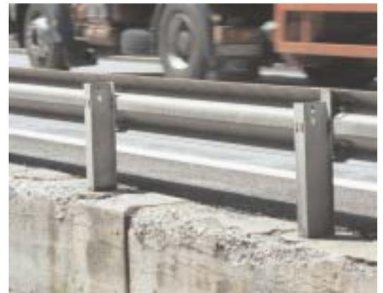
*Betonabplatzungen wegen ungenügender Frost-Tausalz-Beständigkeit des Mauerkordons*
