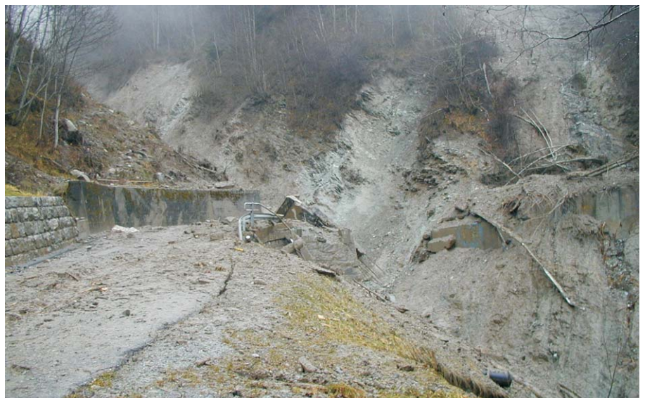
Die Reste der Kantonsstrasse Trun - Schlans im Val Farbertg nach den Unwettern
