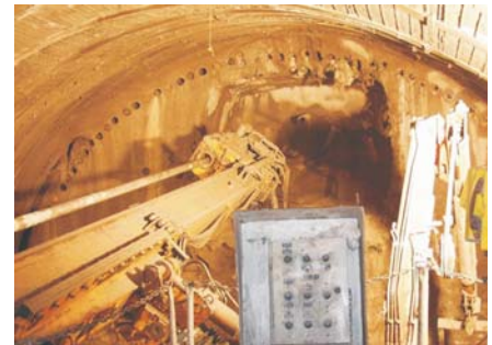
A Erstellen eines Stützgewölbes aus parallelen Jetpfählen mit zusätzlichen Jetpfählen und in der Ortsbrust
