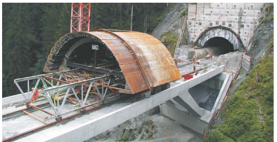
Verschiebung des Messerschildes im Sommer 2002 vom Tunnel Frau Pultè über die Flimbrücke für den fallenden Vortrieb im Lockergestein des Flimsersteintunnels
