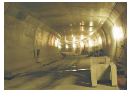
F Einbau Abdichtung 1; Betonieren Innensohlgewölbes 2 und Innengewölbes 3 mit Zwischendecke 4; Erstellen der Fahrbahn 5
