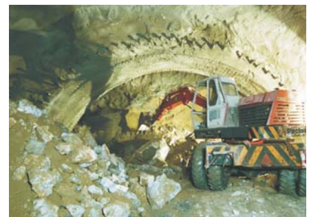
C Erstellen des Aussengewölbes mit Netzen, Gitterträgern und Spritzbeton in Etappen von 1.5 Metern
