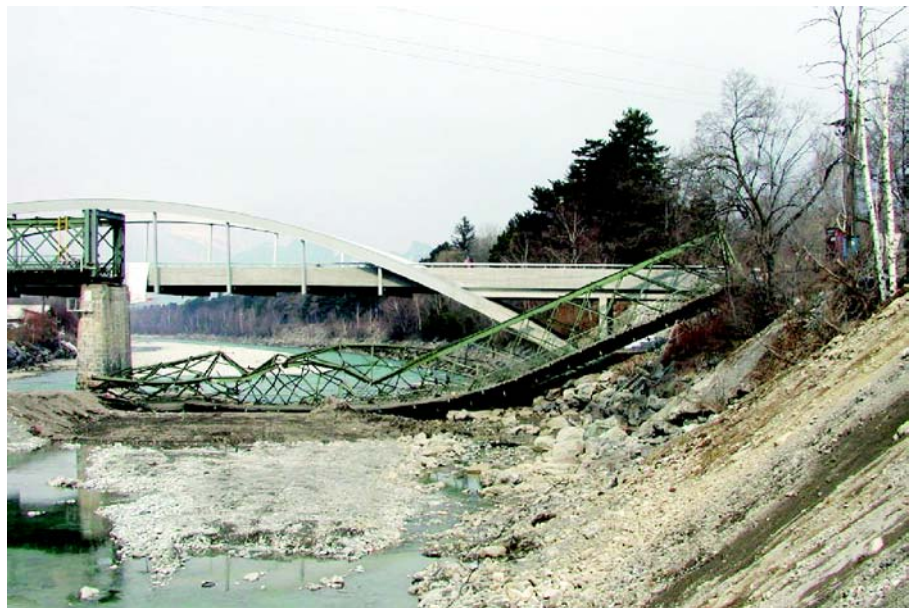
Die erste Fachwerkhälfte liegt im Flussbett, bereit für das Zerkleinern und den Abtransport zur Wiederverwertung.
