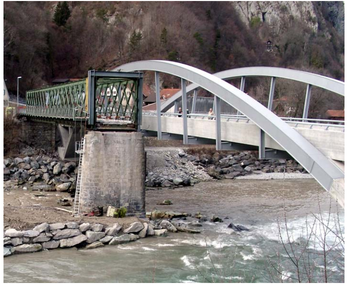
Blick auf den alten Brückenquerschnitt mit der neuen Bogenkonstruktion als Hintergrund
