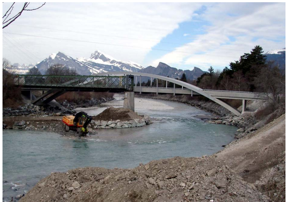
Bau des Ablenkdammes im Rheinbett für den Abbruch der zweiten Brückenhälfte
