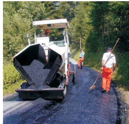
Sanierung eines Asphaltbelages
