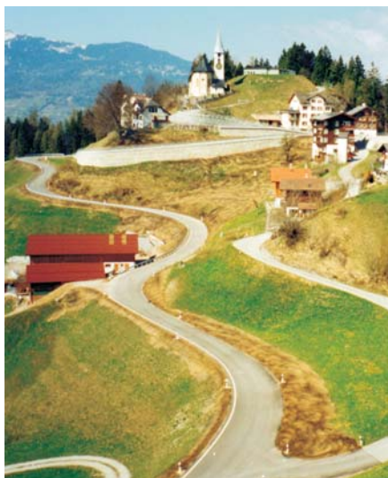
Die neu ausgebaute Lüenerstrasse
