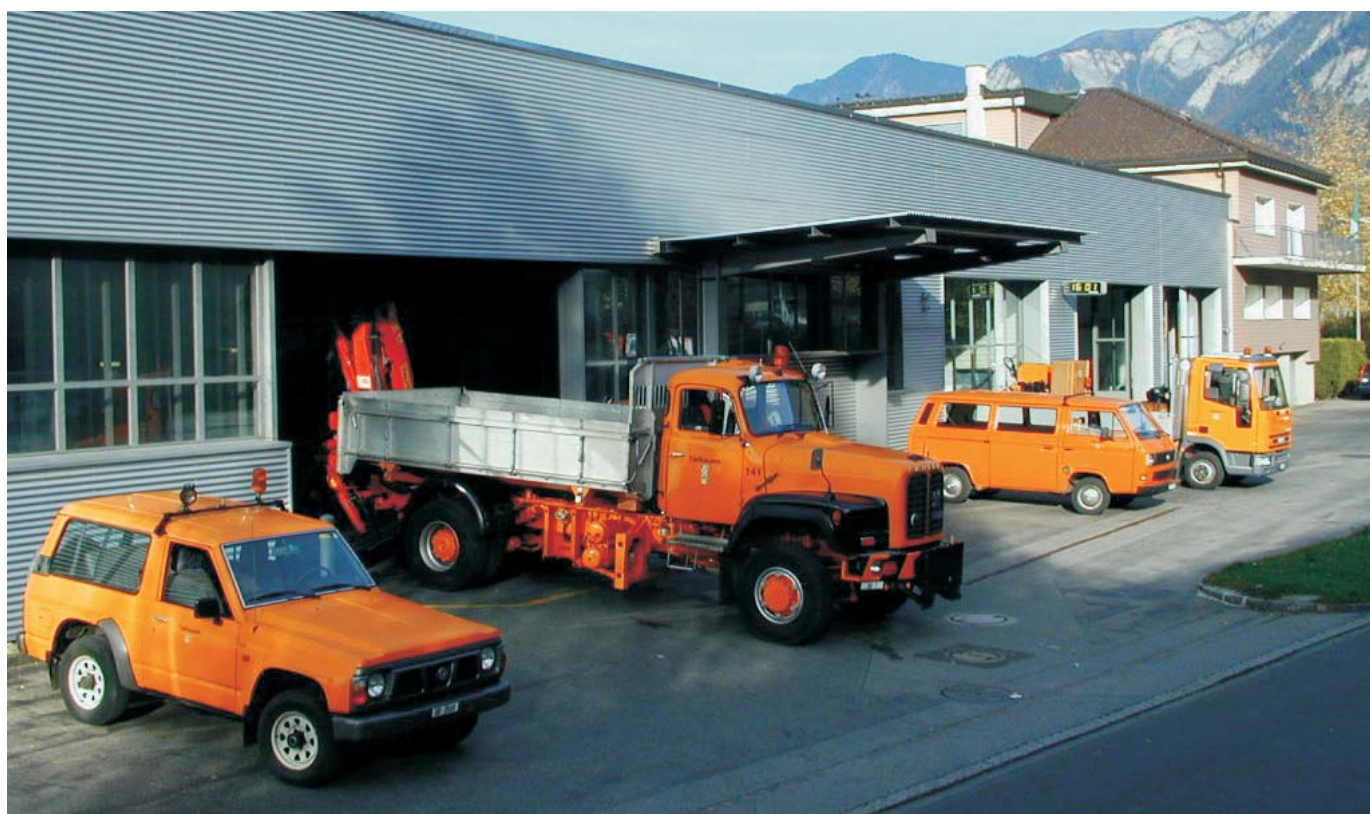
Die Gebäulichkeiten des Bezirkes 1 an der Ringstrasse in Chur mit einem Teil des Fahrzeugparkes
