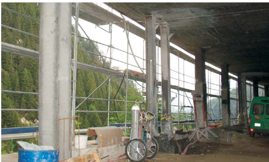
Ausbau der schadhafte quadratischen Stahlbetonstützen und Ersatz durch Schleuderbetonstützen (von rechts) in der Galerie Rofla
