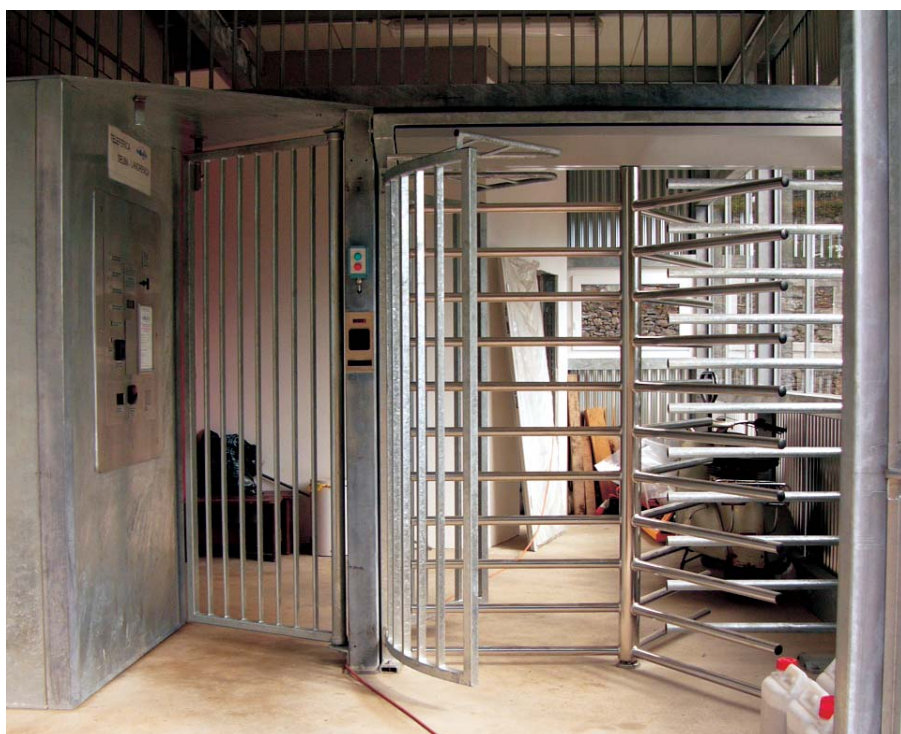
A sinistra la cassa completamente automatizzata e a destra il controllo d'accesso. Links der vollautomatisierte Kassenautomat und rechts die Zugangskontrolle.
