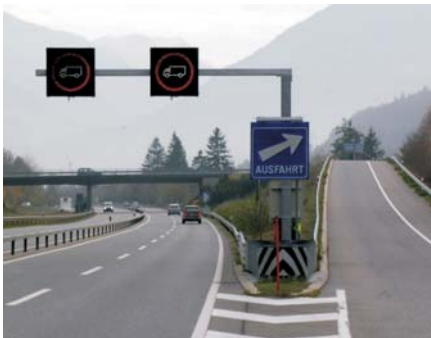
Elektronisch gesteuerte Signale leiten den Schwerverkehr von der A13 über den Anschluss zum Kontrollzentrum.
