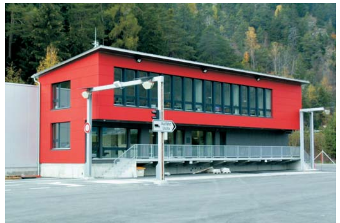
Das Betriebsgebäude mit vorgelagerten Wägeeinrichtungen und Profiler für das Überprüfen der Fahrzeugabmessungen
