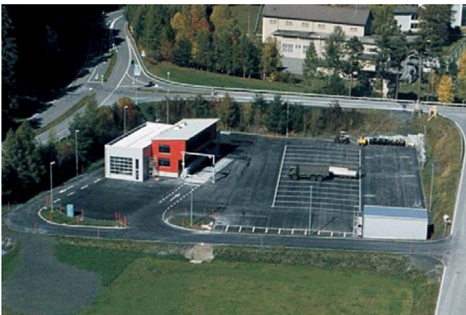
Das Schwerverkehrszentrum mit der Prüfbahn und der Prüfhalle, Abstellplätzen und den Büroräumlichkeiten für das Personal
