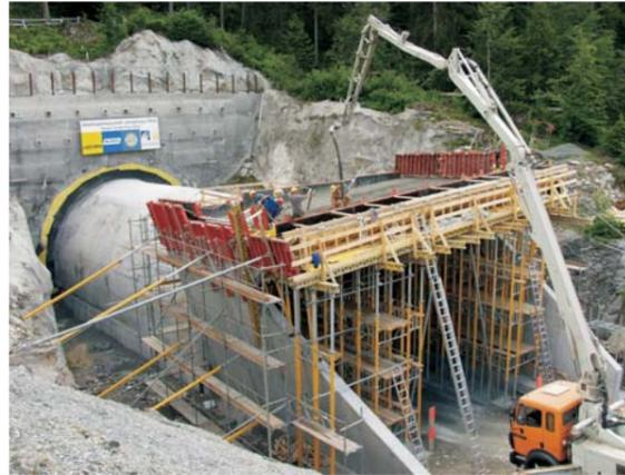
Das betonierte Aussengewölbe in der Lockergesteinsstrecke
