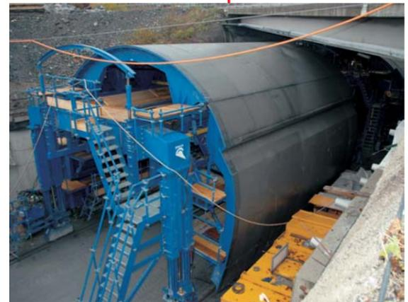
Innenring-Schalung bereit zur Verschiebung in den Tunnel
