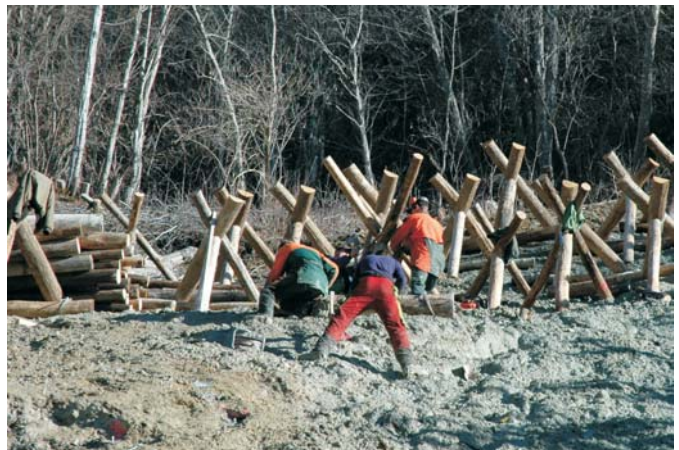
Erstellen der Dreibeinböcke in der steilen Tobelflanke Ils chavalluts da trais chommas en la vart taissa da la val
