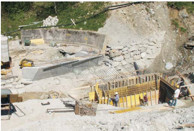
Bau der Brückenwiderlager im Val Farbertg La construcziun dals cuntraforts da la punt en la Val Farbertg
