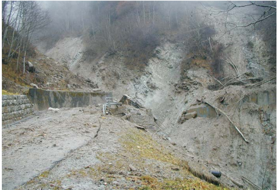
Die Überreste der Strasse Trun - Schlans im Val Farbertg nach den Unwettern Las restanzas da la via chantunala Trun - Schlans en la Val Farbertg
