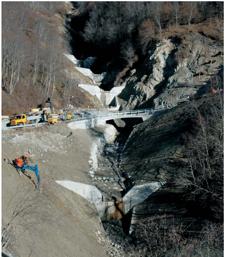
Die neue Brücke im Val Farbertg und die mächtigen Bachsperren aus Beton La nova punt en la Val Farbertg e las fermas bloccadas da l'ual or da betun
