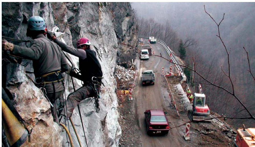
Bei den Sicherungsarbeiten war alpinistisches Können gefragt. Lavori alpinistici di sicurezza.
