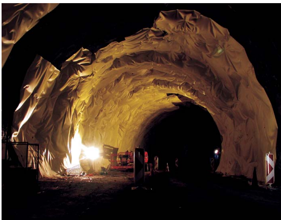
Isolazione contro le acque d'infiltrazione mediante fogli sintetici. Auskleiden des Tunnelgewölbes mit einer Kunststoffolie als Schutz gegen das Bergwasser.
