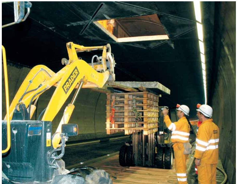
Die neu geschaffene Öffnung in der Zwischendecke ist bereit für die Installation einer Rauchabsaugklappe.
