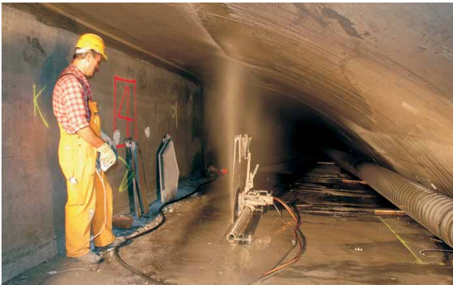
Fräsen der Öffnung im Abluftkanal
