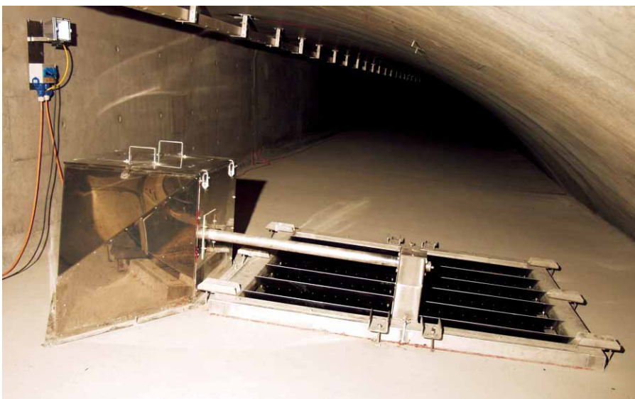
Beispiel einer betriebsbereiten Rauchabsaugklappe
