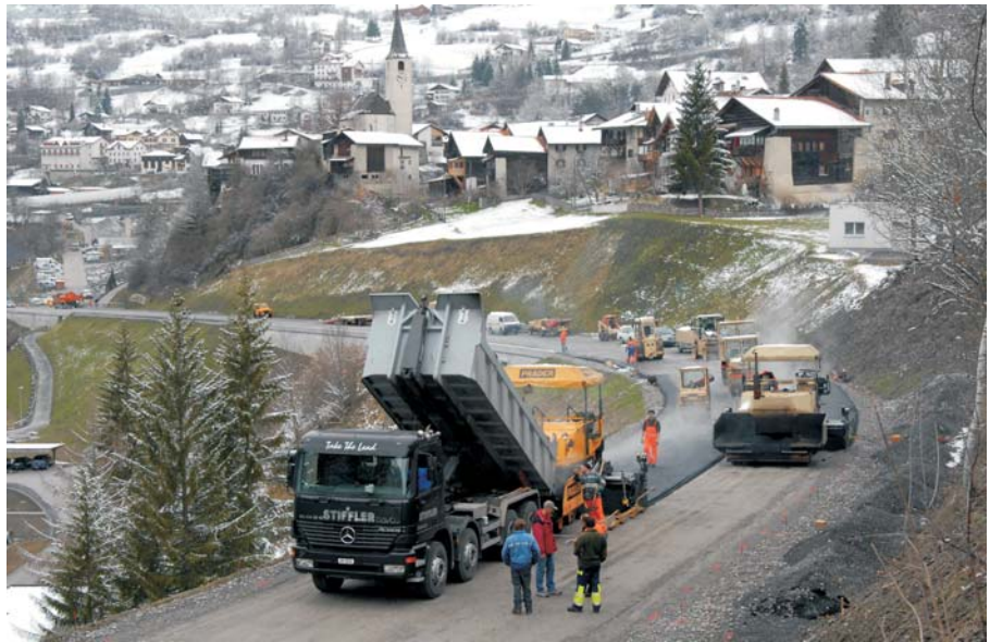
Belagseinbau Mitte April 2006.
