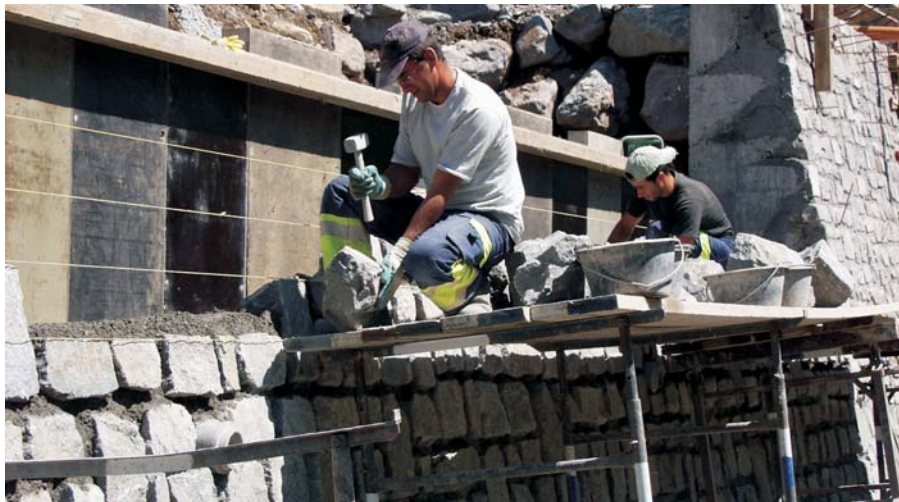
Aufwändig gearbeitete Stützmauern mit Steinverkleidung nehmen Rücksicht auf das geschützte Ortsbild.
