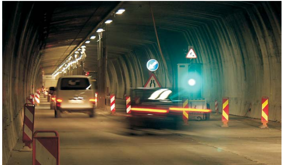
Die Baustelle im Innern des San Bernardino Tunnels mit einspuriger Verkehrsführung wurde während der Gotthardsperre aufgehoben für den ungehinderten Verkehrsfluss im für 30 Tage wichtigsten schweizerischen Alpendurchstich.
