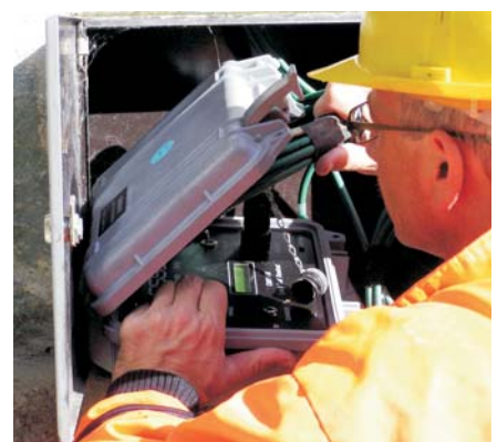
Ablesung der gemessenen Ankerzugkraft, Italienische Strasse, Rofla
