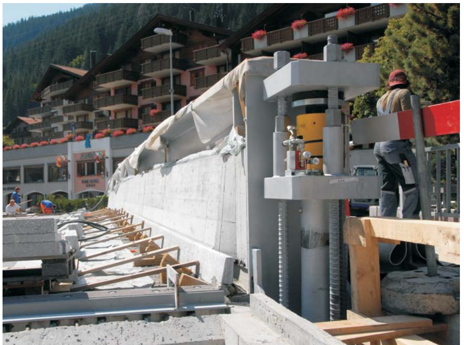
Eine der vier Hebevorrichtungen im abgesenkten Zustand der Brücke
