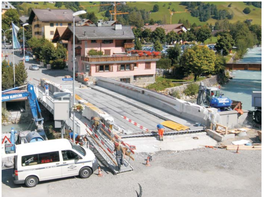
Die neue Landquartbrücke vor dem Einbringen des Fahrbahnbelages
