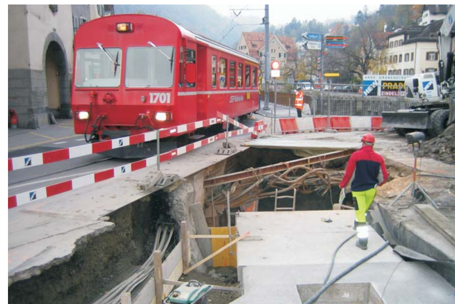
Das Bauen unter Verkehr und die sehr beengten Platzverhältnissen erfordern gut durchdachte Abläufe und auch viel Verständnis von allen Beteiligten.
