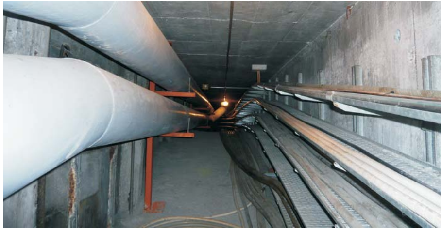
Die Werkleitungen im Brückenkasten der Brückenverbreiterung von 1931
