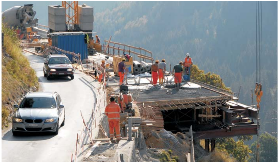
Betonieren einer Brückentappe unter Verkehr. Ina etappa da la punt vegn betunada cun traffic.
