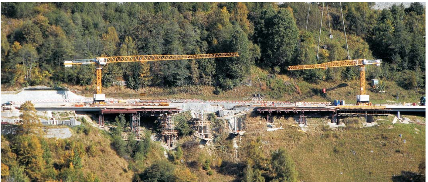
Blick auf die Linienbaustelle vom Gegenhang. Vista da l'autra vart da la val sin il piazzal da fabrica.
