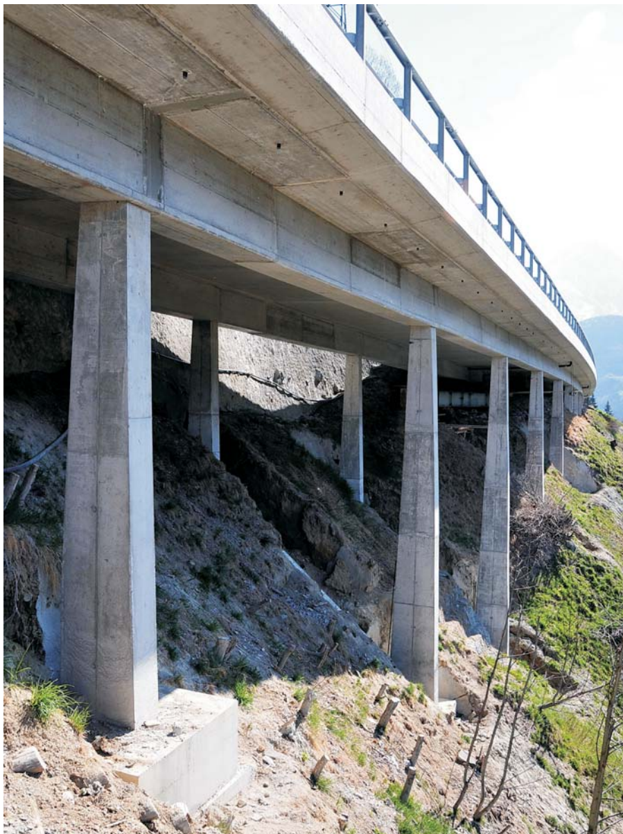
Die bereits dem Verkehr übergebene erste Bauetappe. L'emprima etappa da la renovaziun ch'è puspè charrabla normalmain.
