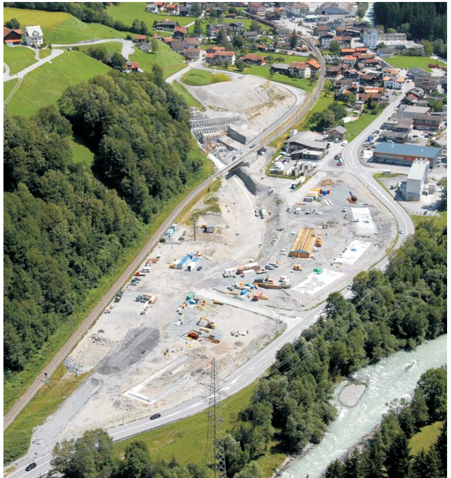
Der Voreinschnitt Dalvazza mit dem Installationsplatz und der für die Bauzeit der Umfahrung verlegten Prättigauerstrasse
