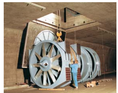
Montage eines Ventilators
