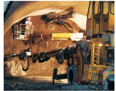
Bohren der Sprenglöcher an der Kalottenbrust
