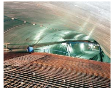
Armierung der Zwischendecke
