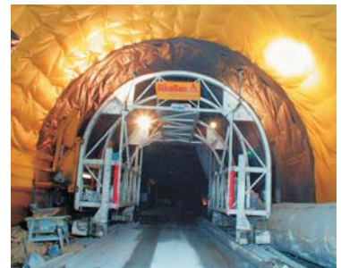
Abdichtung mit ausgeschalttem Innengewölbe
